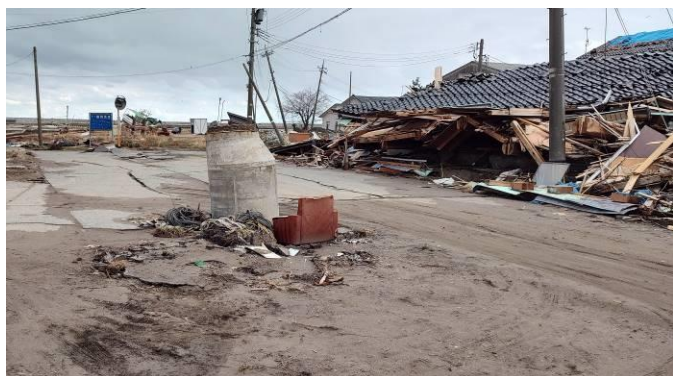
写真 11 鵜飼川を挟んで海側で見られた被害
