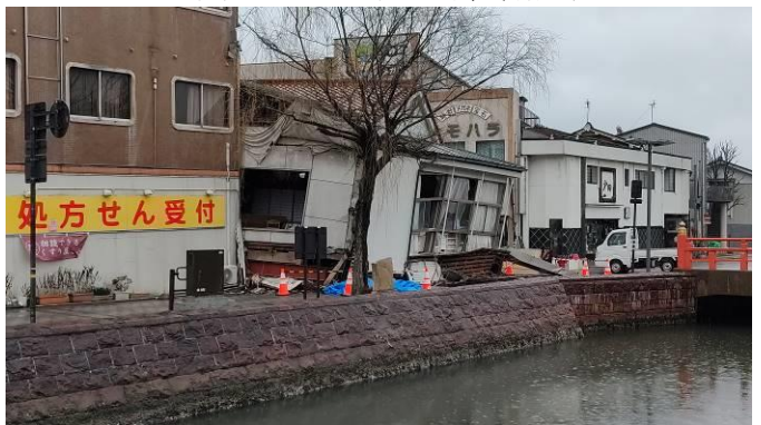
写真8 木造建物の倒壊
