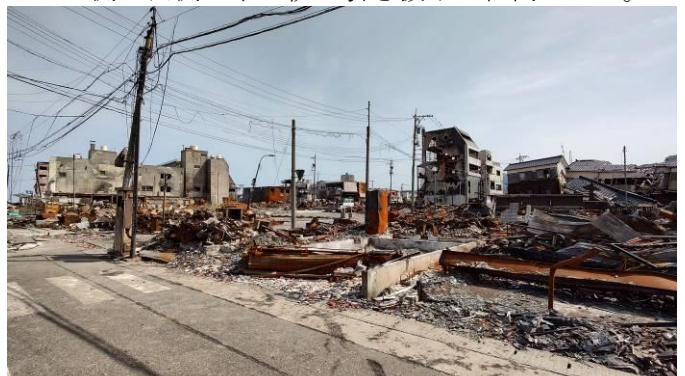
写真6 輪島朝市の火災跡
