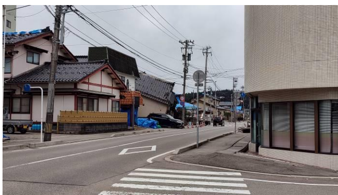
写真4 穴水駅前の木造住宅被害
