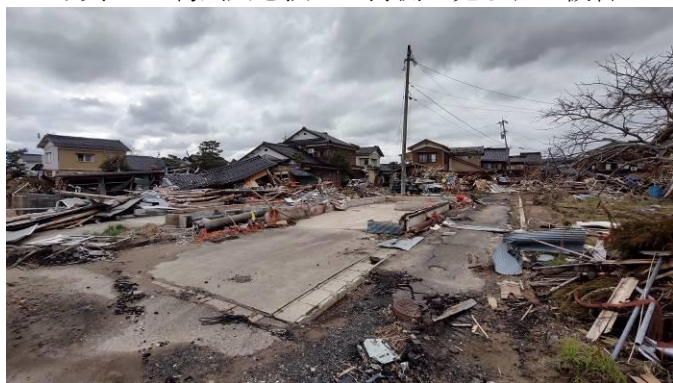
写真 15 流失した住宅跡
