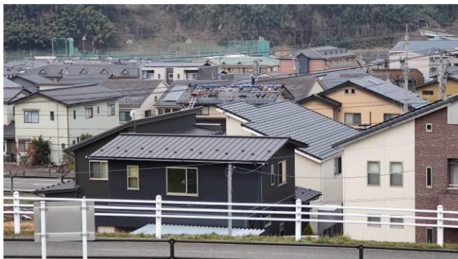
写真4 棟瓦の修理中
