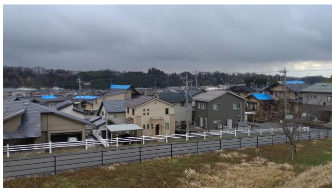
写真3 周辺地域では棟瓦の被害が散見された
