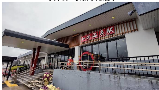
写真12 和倉温泉駅（調査時は水道復旧前）
