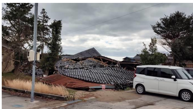
写真3 倒壊した木造住宅
