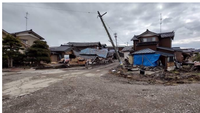
写真 12 鵜飼川を挟んで海側で見られた被害
