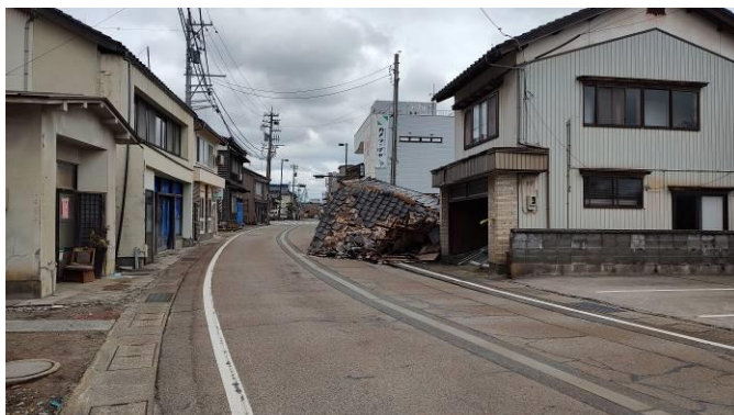
写真4 木造建物の倒壊
