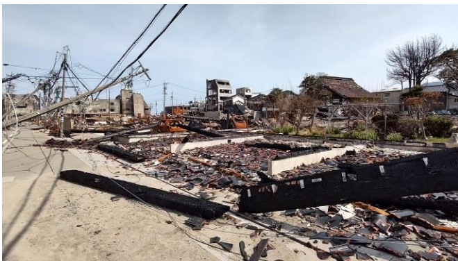
写真5 輪島朝市の火災跡
