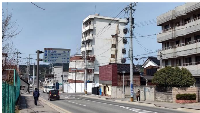
写真11 転倒まではいかないが傾斜したRC造
