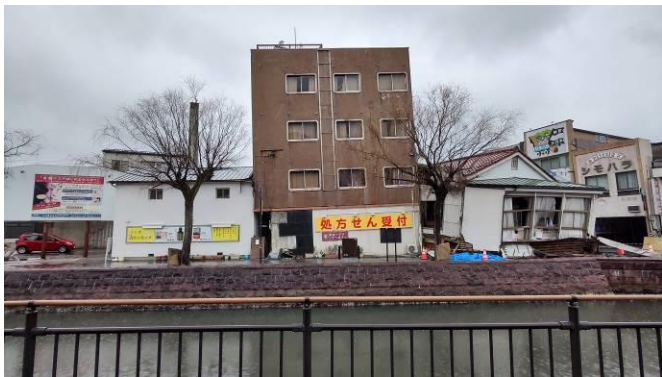
写真9 4階建てビルの傾斜と隣接建物への衝突
