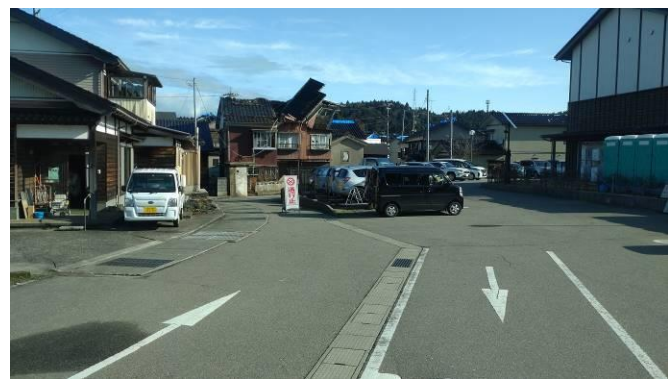
写真8 上層階の崩落被害
