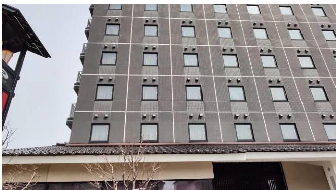
写真 19 津波避難ビル外壁には特段損傷見られない
