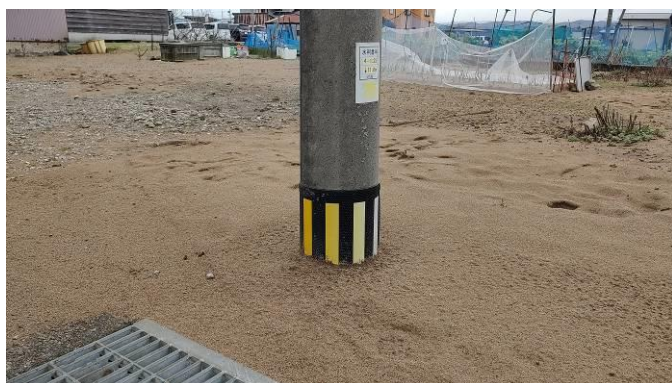
写真4 電柱沈下
