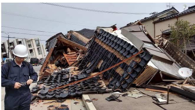
写真 23 歩道にはみ出た倒壊建物造
