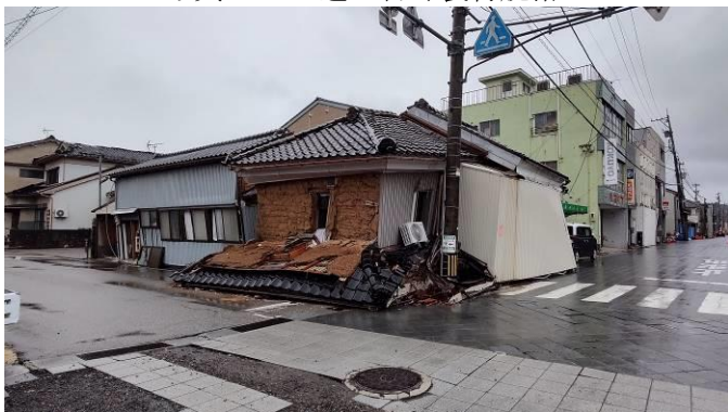
写真 19 土壁の建物被害
