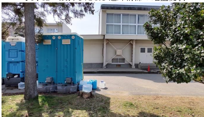
写真14 S造講堂の柱の傾斜 (高校)
