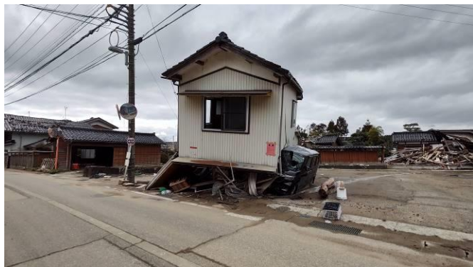
写真1 震動による倒壊
