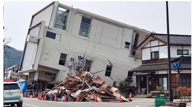
写真4 背面の下側になっている壁にせん断ひび割れ 先に東側半分の沈みこみが生じ、引っ張られる形で残った側の西側の下の杭が引き抜けて転倒したか。
