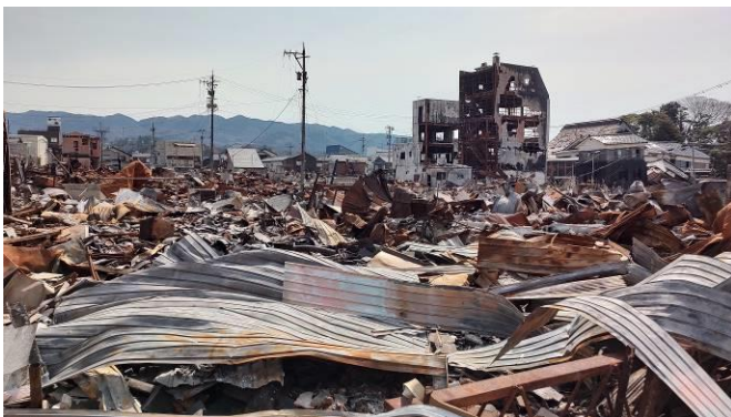
写真7 輪島朝市の火災跡
