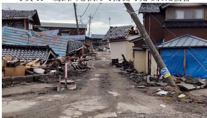
写真 13 鵜飼川を挟んで海側で見られた被害
