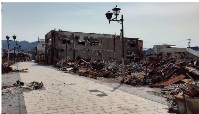
写真10 この建物より奥は延焼していない
