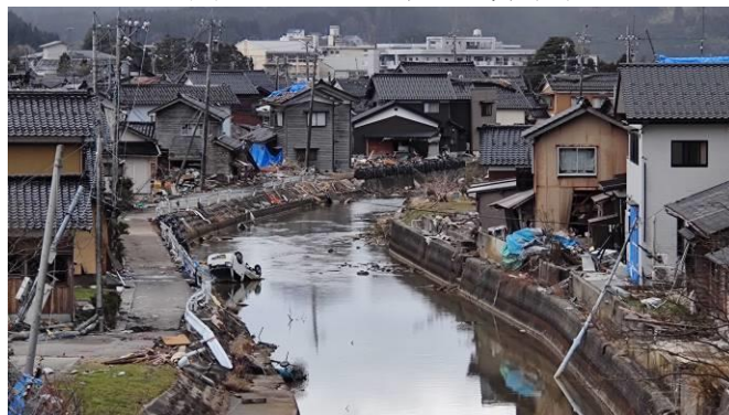
写真10 津波の痕跡が残る鵜飼漁港周辺の集落
