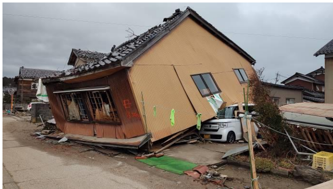
写真2 震動による倒壊
