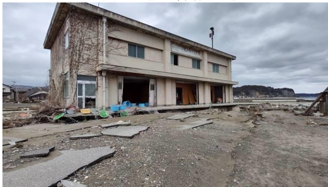
写真 18 RC造2階建て施設
