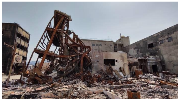
写真8 輪島朝市の火災跡
