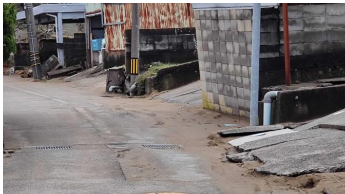
写真8 南東方向への沈下が続出
