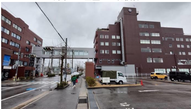
写真 21 恵寿総合病院 3 病棟と 5 病棟を結ぶ連絡橋
