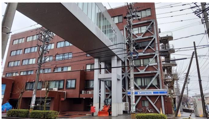
写真 25 3 病棟側は耐震補強されている
