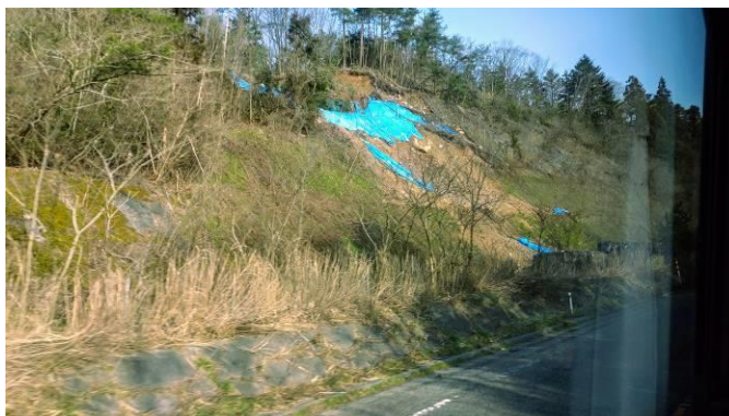
写真2 道路わきの斜面崩壊
