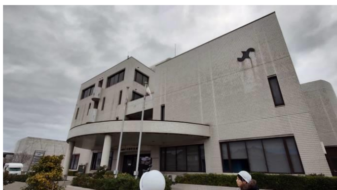
写真13 飯田港周辺のRC造建物
