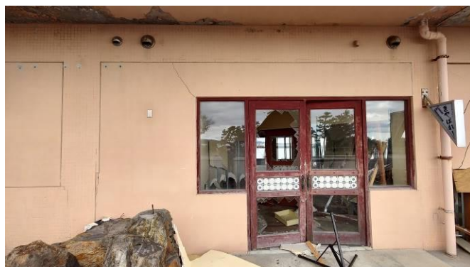
写真10 背面側では扉取手より20cmほど上部まで浸水したと思われる
