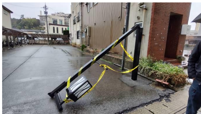
写真10 折損した電灯
