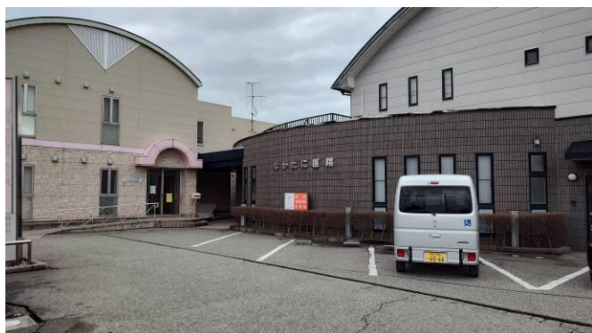
写真1 基礎周りの被害
