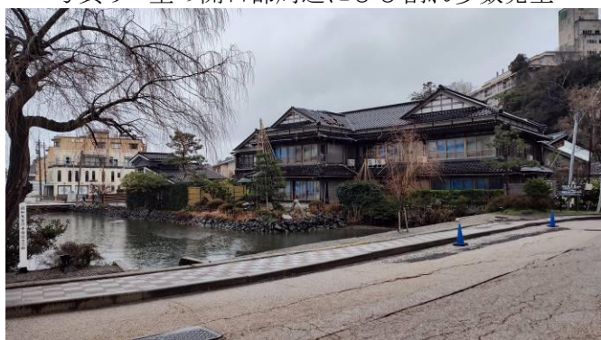
写真11 趣のある木造施設の被害
