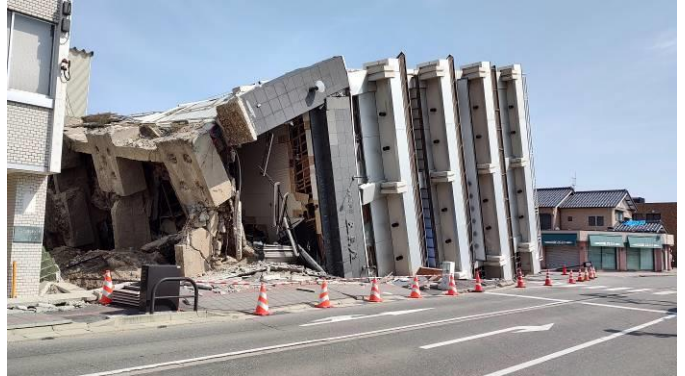
写真2 基礎に杭頭跡が見える
