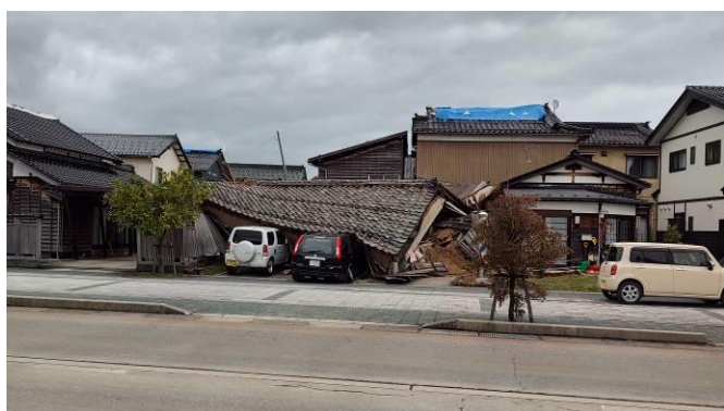
写真3 木造建物の倒壊
