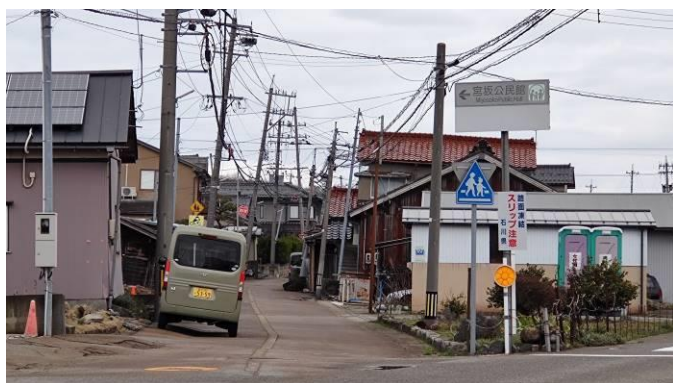
写真3 電柱が傾斜
