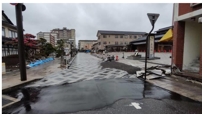
写真1 地盤変状が見られる
