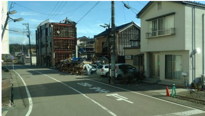
写真6 駅前のS造建物外装材脱落と倒壊店舗跡
