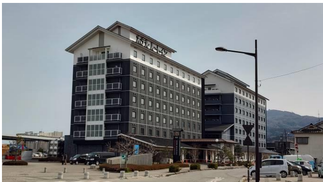
写真 17 輪島港周辺の津波避難ビル
