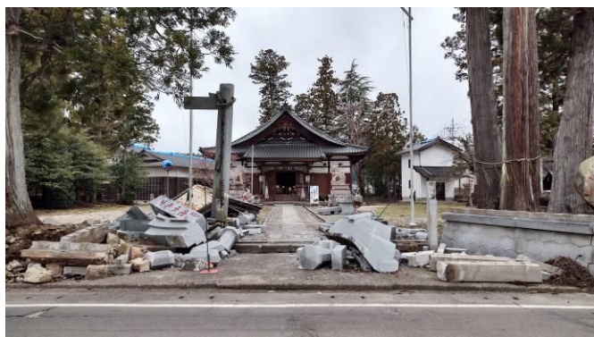
写真5 穴水大宮の鳥居被害
