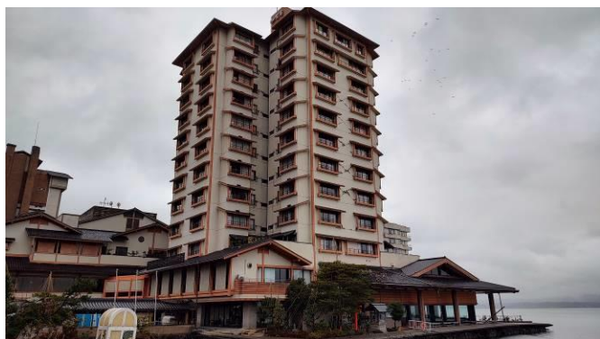
写真7 5～9層の壁にせん断ひび割れ
