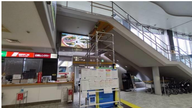
写真4 階段部分の応急措置
