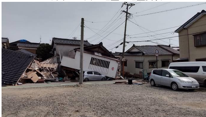
写真 22 河井町の木造住宅被害
