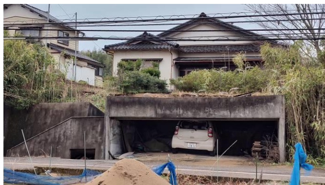
写真5 車庫の沈下
