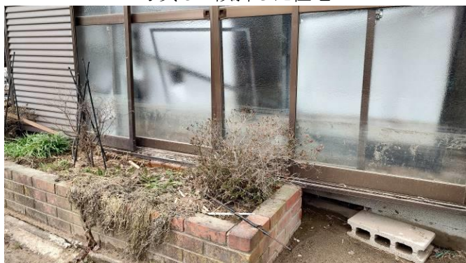
写真5 鵜飼川を挟んで内陸側の浸水跡 (80cm程度)
