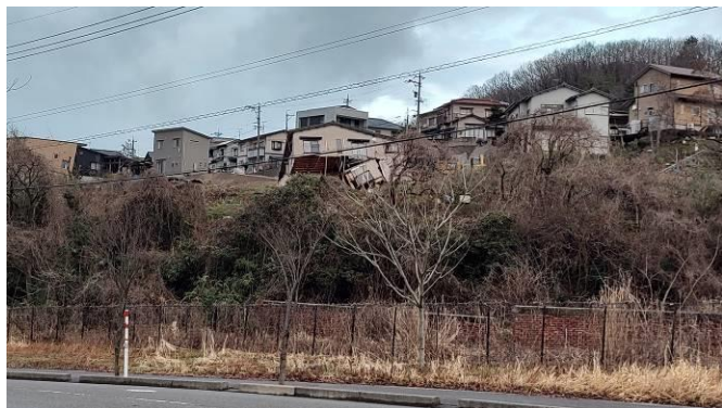
写真1 盛土崩落による被害
