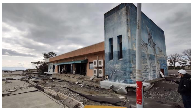
写真3 津波被害を受けた建物
