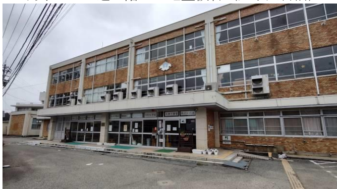
写真8 穴水小学校(1970年竣工) 一部ブレースによる耐震補強済み
