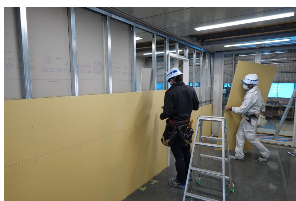
▲軽量鉄骨下地(LGS)間仕切り壁 軽量鉄骨で骨組みを作り、そこに石膏ボードを貼って壁を作る非構造部材。遮音性や断熱性に優れ、用途に応じて空間を仕切る役割がある。
