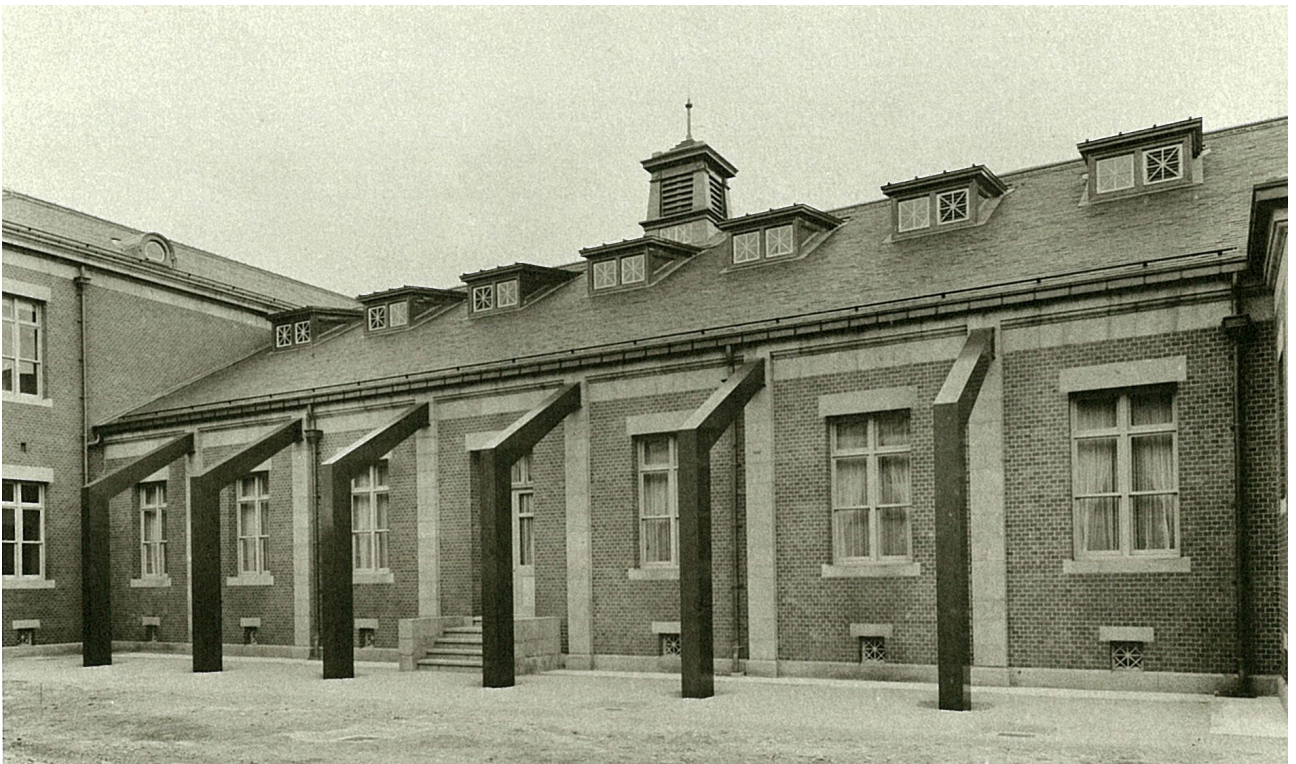
図6：復原・修理後 議場棟東面
