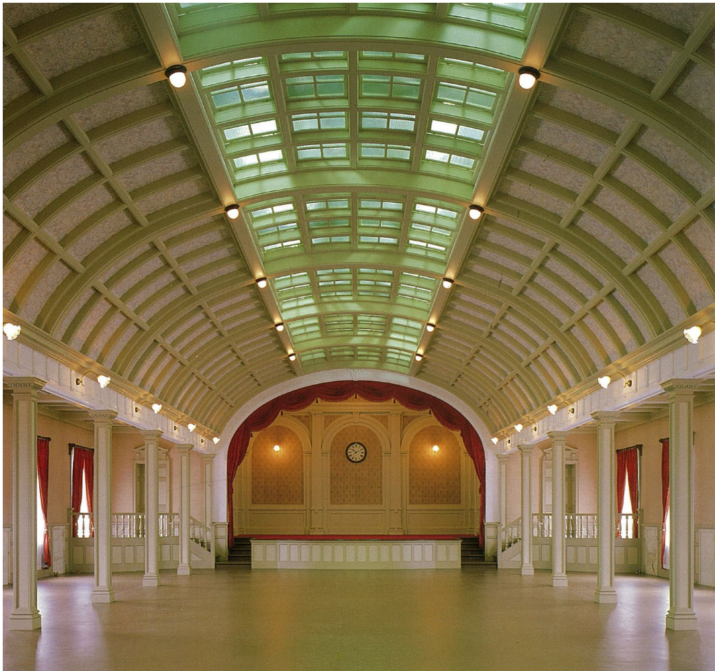
図3：復原・修理後 議場 南中央入口より見る
