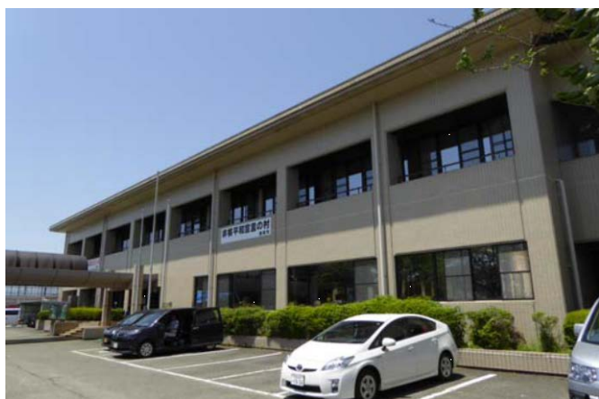
写真3 外観からは構造被害は見当たらない
