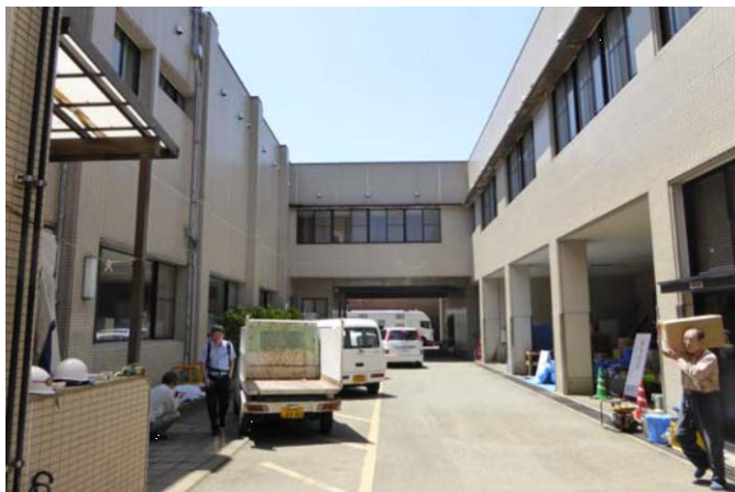
写真6 震度計設置個所近傍の渡り廊下にも被害なし
