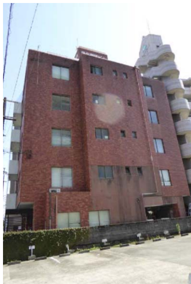
写真5 北側構面は壁が比較的多い
