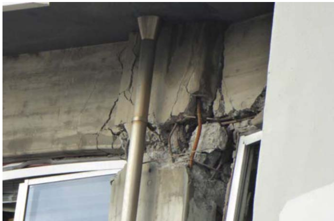
写真10 5階柱頭被害
