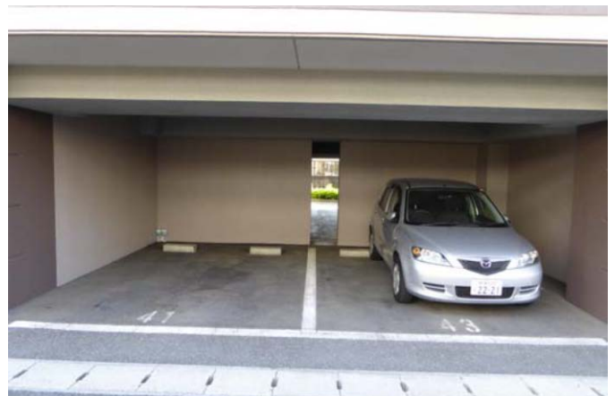
写真6 1階の柱・壁は無損傷
