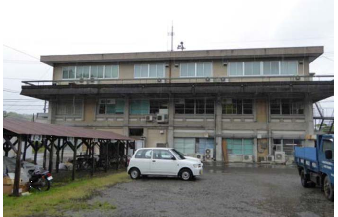
写真2 人吉市本庁舎 (東面)
