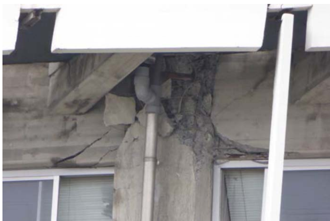
写真8 4階柱梁接合部被害
