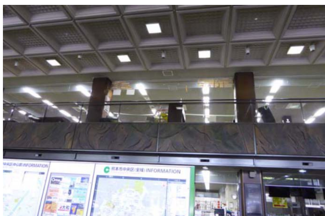
写真3 2階防煙ガラスの破損
