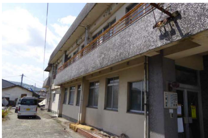
写真3 構造的被害は見られなかった。
