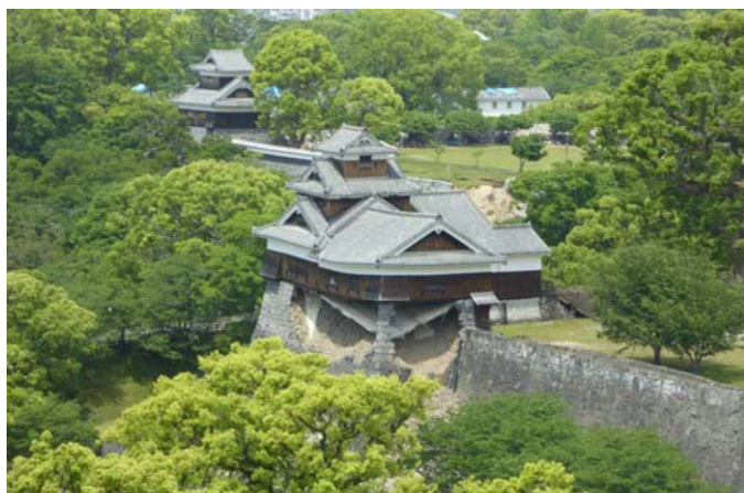
写真3 飯田丸五階櫓下部石垣の崩落
