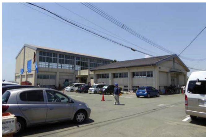
写真7 村民体育館の妻壁外装材一部脱落
