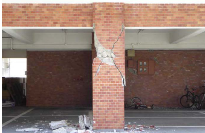
写真3 中柱がせん断破壊
