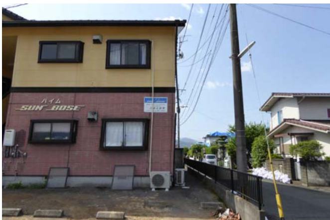
写真13 東西方向に6度傾斜した木造共同住宅
