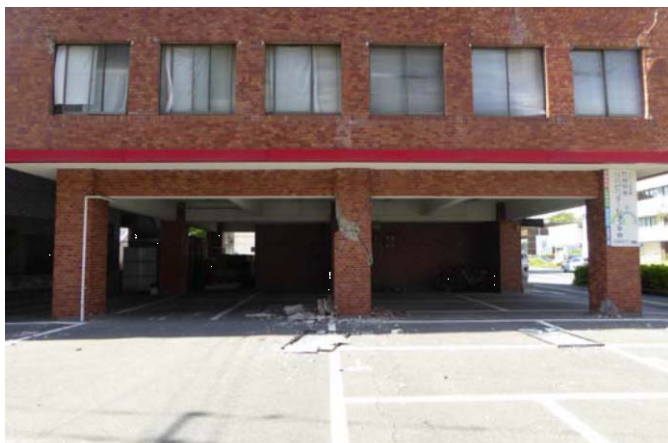
写真2 ピロティ一部的様子（南構面）
