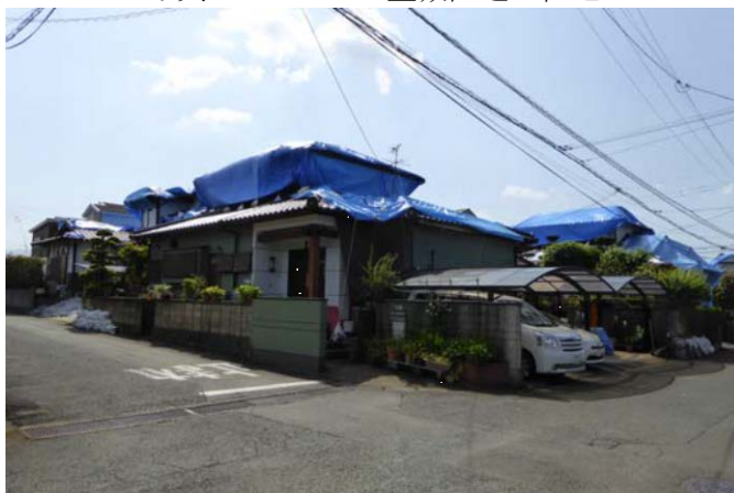
写真12 KiK-net 益城周辺だと瓦屋根被害が多い
