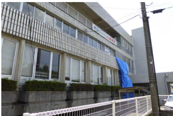
写真2 ガラスの割れ
