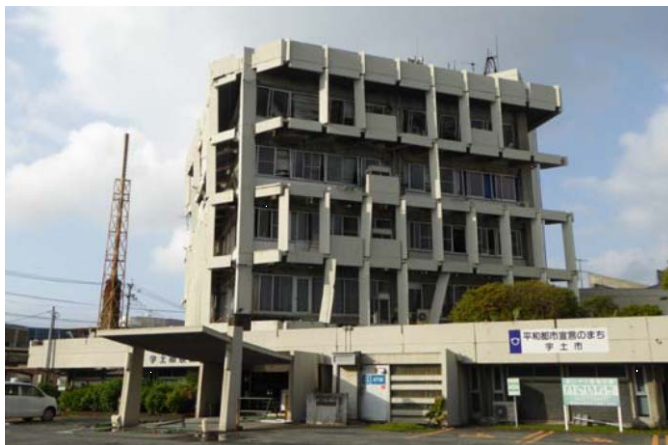
写真2 市庁舎（南東構面）
