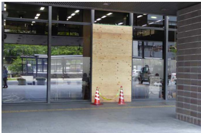
写真2 1階ガラスの破損
