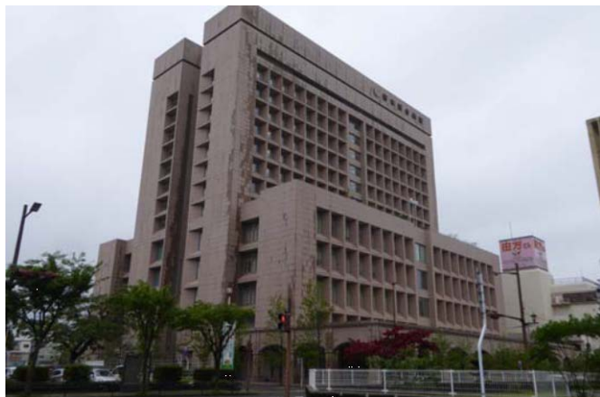
写真1 市庁舎となりの K 総合病院
