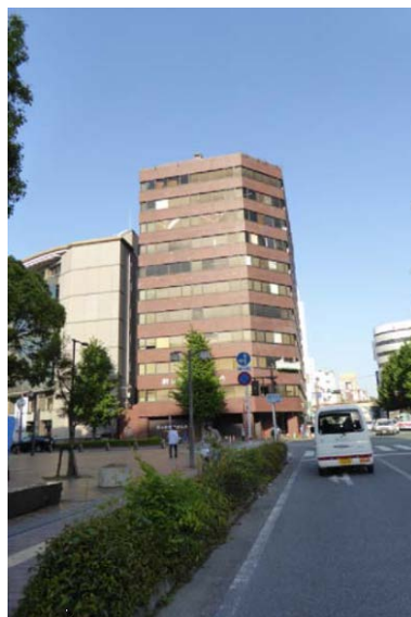
写真2 Aビル (ガラス被害)
