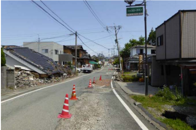
写真1 大きい通り沿いの被害状況
