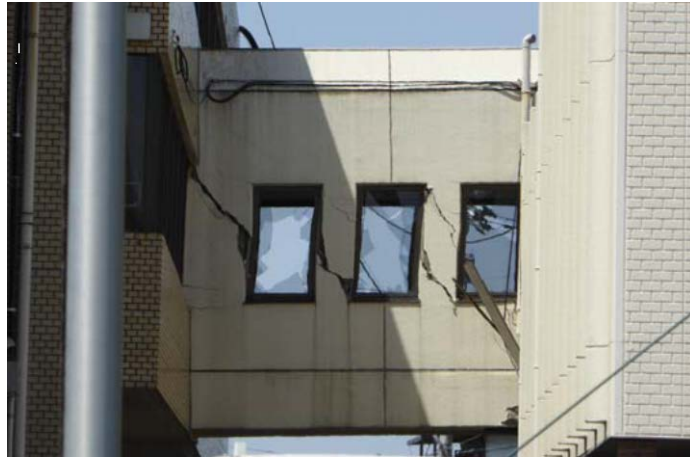
写真2 渡り廊下部分の被害
