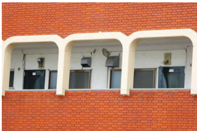
写真3 雑壁被害とドア変形
