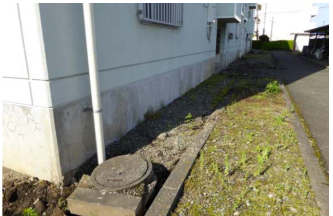
写真6 団地北側の基礎周り
