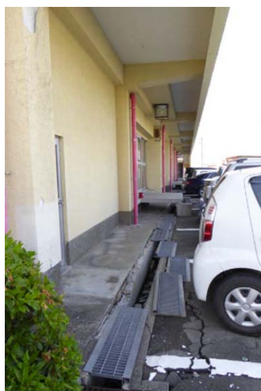
写真8 基礎周りグレーチングのはずれ
