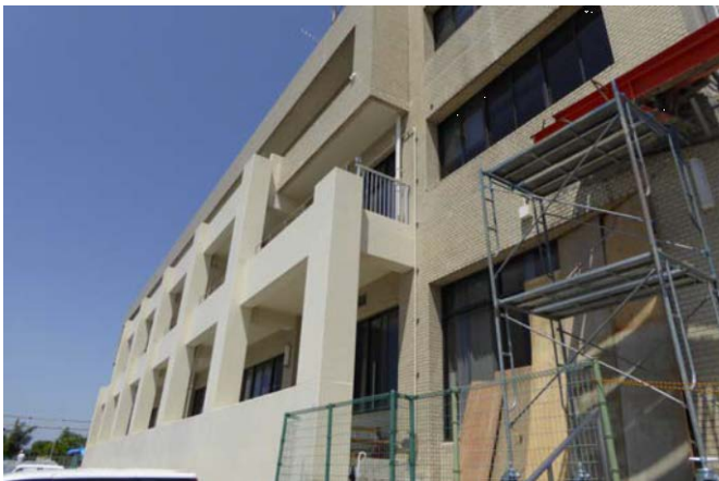
写真3 外付けフレームによる耐震補強
