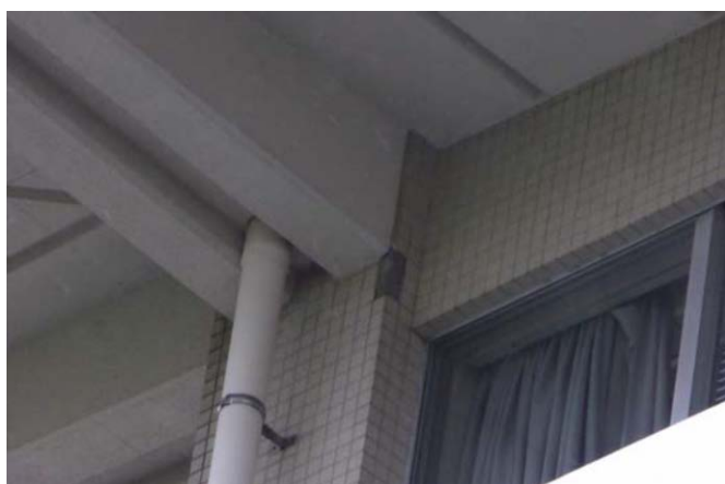
写真5 5階柱頂部タイル一部剥落
