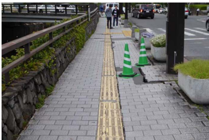
写真6 お壕沿いの歩道に変状
