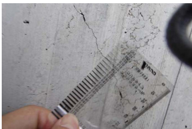
写真7 南構面耐力壁(厚 200)最大ひび割れ幅 0.2mm
