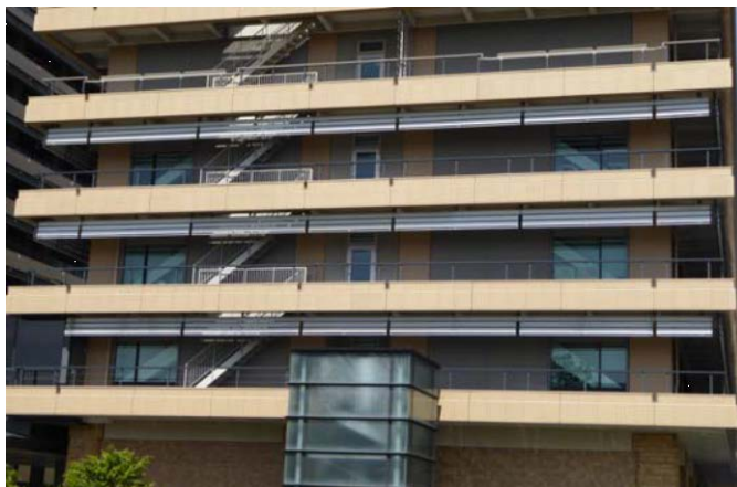
写真 2 (本館) 2002 年にブレース補強済み
