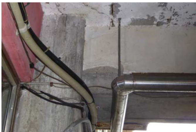
写真6 北面平屋とのつなぎ梁端部に一部剥落
