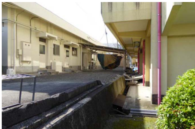
写真5 盛土擁壁の倒壊（左：公民館，右：体育館）
