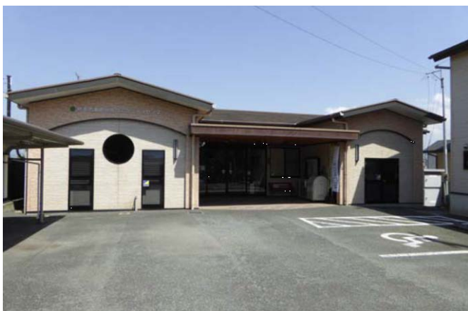
写真3 市東部土木センターには構造被害なし
