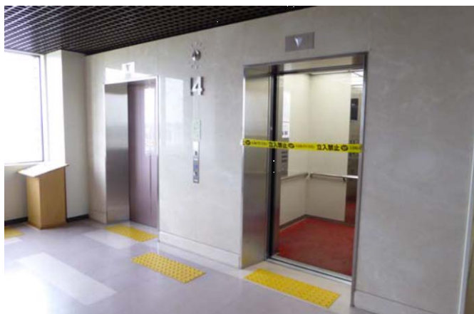
写真7 庁舎北側のEV停止中
