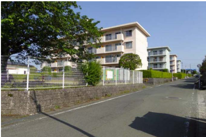
写真3 公民館北側のRC造壁式集合住宅(盛土あり)
