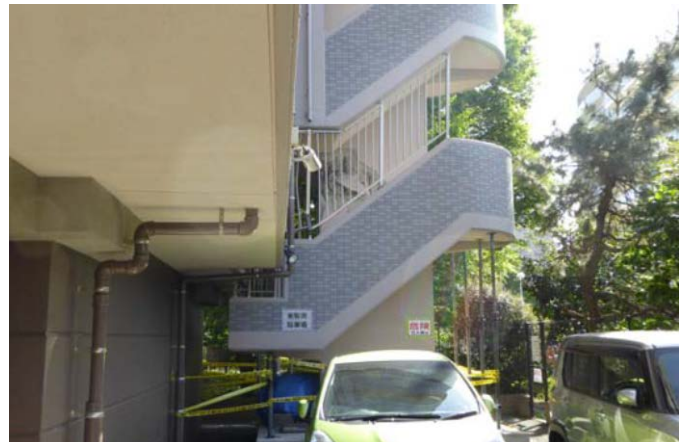
写真4 2階と連動した外階段が1階部分と衝突
