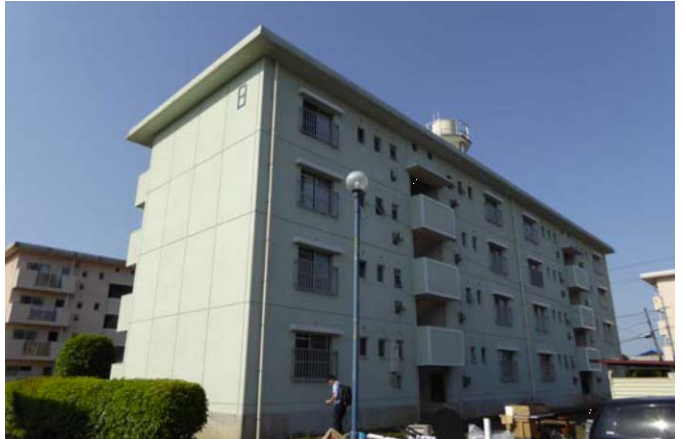
写真4 RC造壁式4階建て住宅
