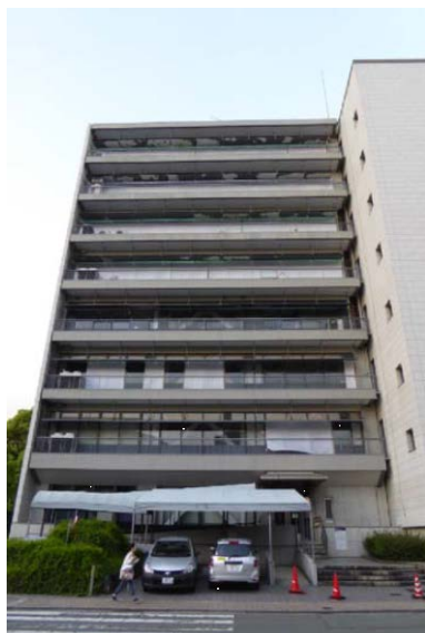
写真1 Nビル (ガラス被害)
