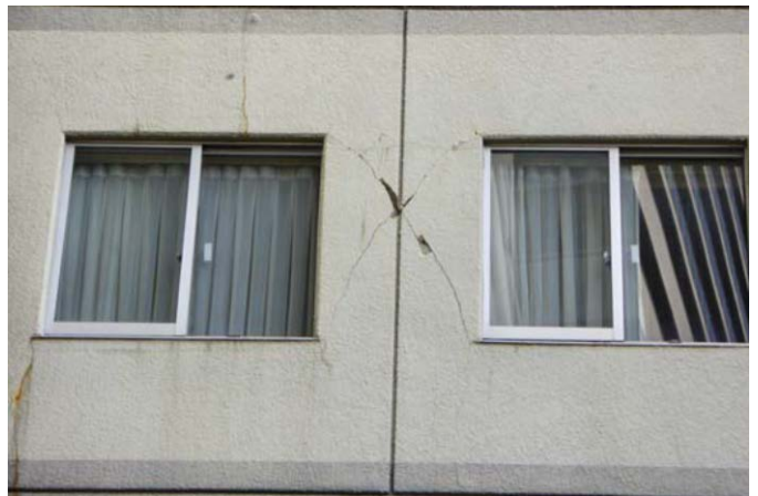
写真3 南構面外壁被害
