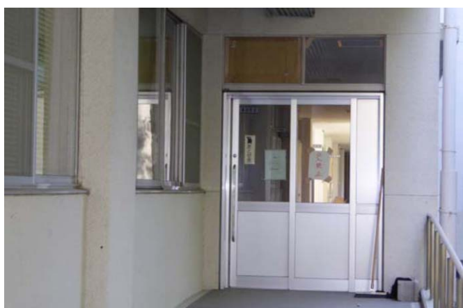
写真3 羽目殺しガラス破損
