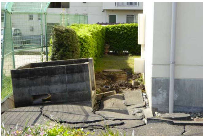
写真7 町営住宅東面の地盤に隙間
