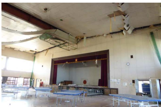
写真5 天井材落下被害
