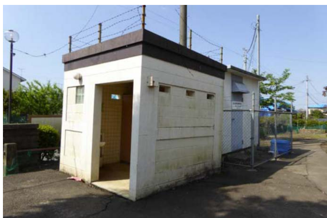
写真3 左の公衆便所はやや傾斜している
