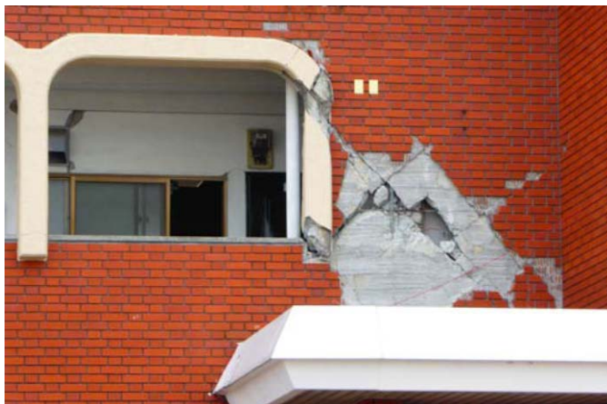
写真2 外壁のせん断ひび割れ
