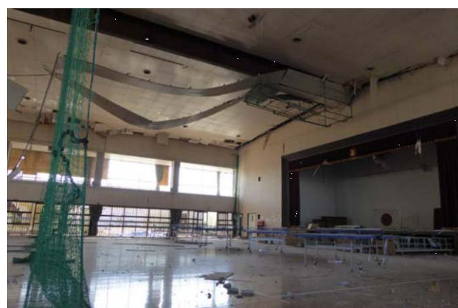
写真4 天井材落下被害
