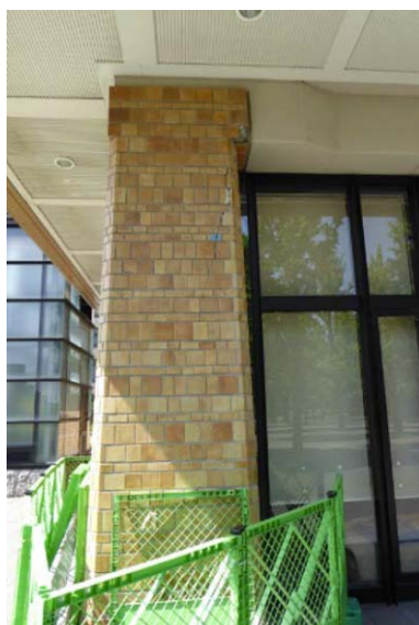
写真 3 (本館) 1 階柱外装材にひび割れ
