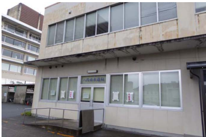
写真6 市庁舎北側に水道局の建物（使用禁止）
