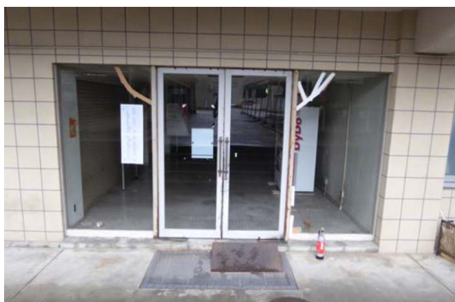
写真3 通用口のはめ殺しガラスにひび
