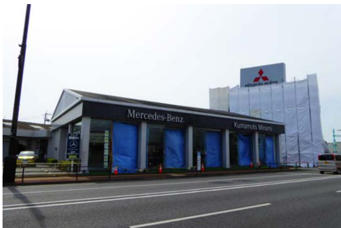
写真2 ショーウィンドウの破損
