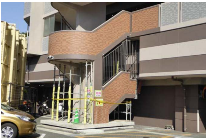
写真3 2階と連動した外階段が1階部分と衝突
