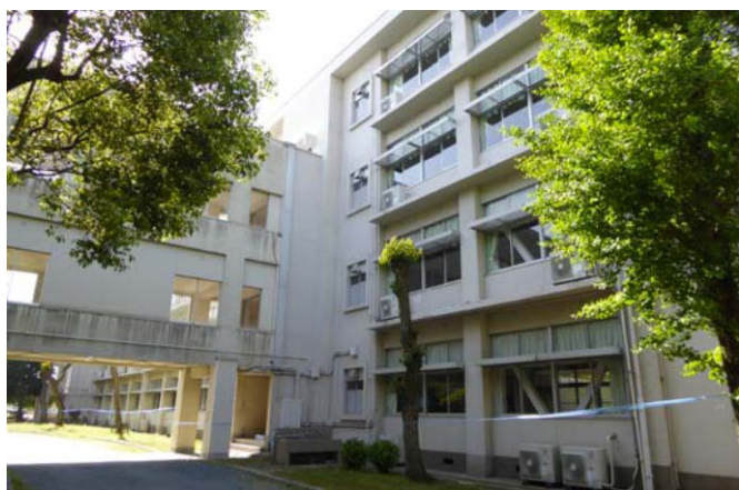
写真1 ブレース補強済みの校舎
