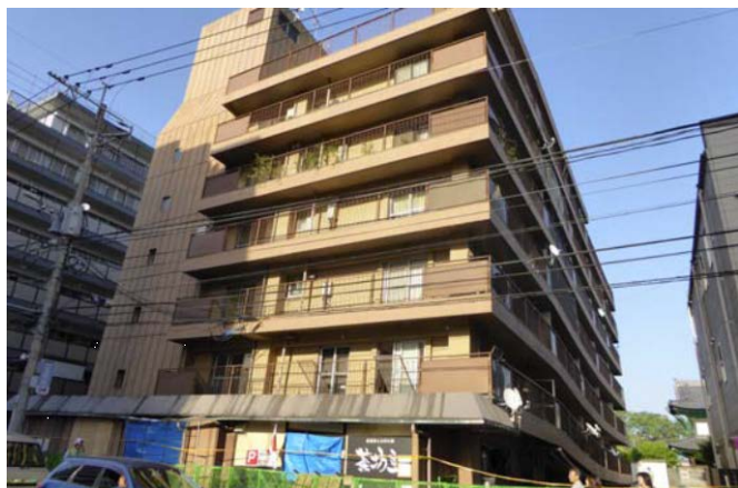
写真1 建物全景（南西構面）
