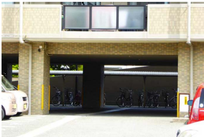
写真2 1階ピロティには被害なし
