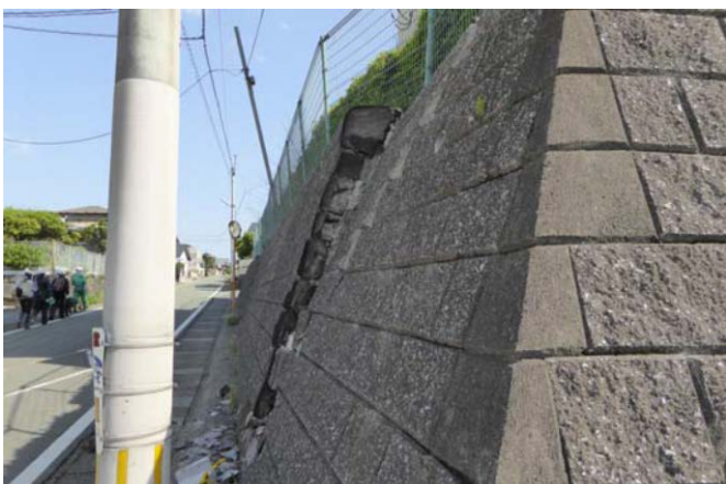
写真 5 町営住宅の擁壁はらみだし
