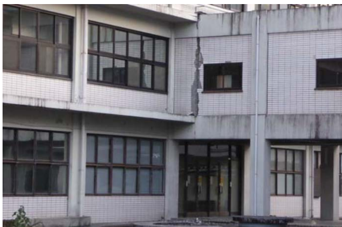
写真2 1号館と管理棟の連絡通路にひび割れ
