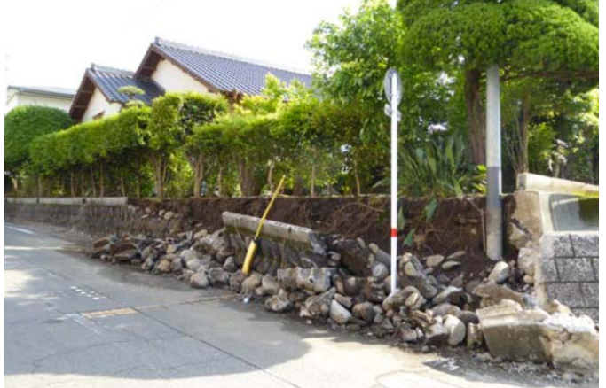
写真2 擁壁の崩落被害
