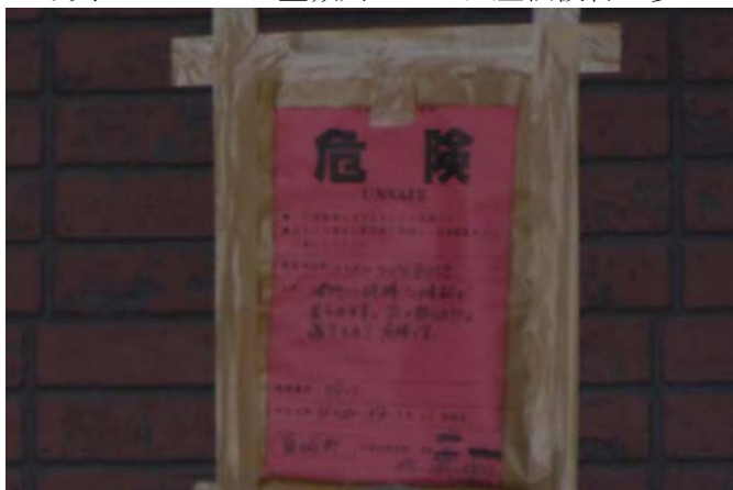
写真14 応急危険度判定済み（赤判定）
