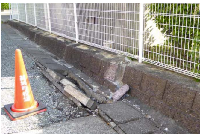
写真12 団地の盛土擁壁部のずれ
