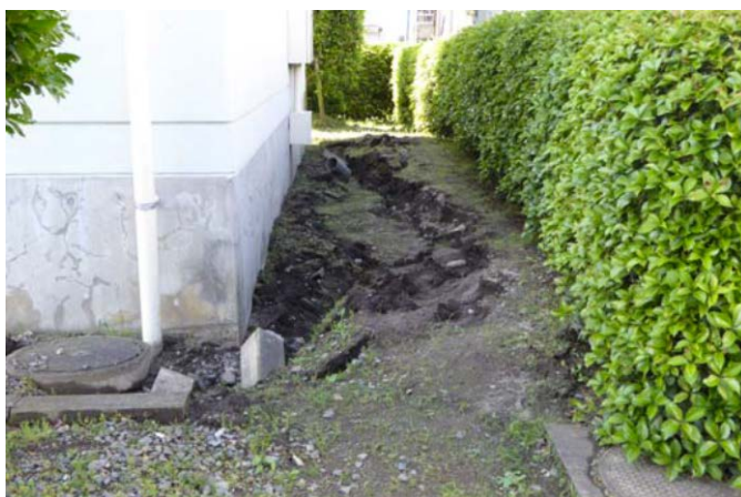
写真10 建物西側地盤の状況
