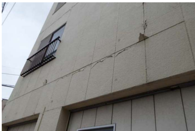
写真3 ALCパネルの亀裂
