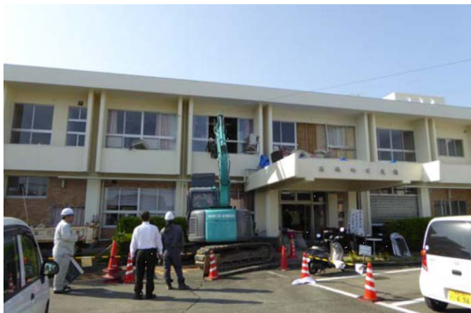
写真2 公民館（内部の瓦礫撤去中）
