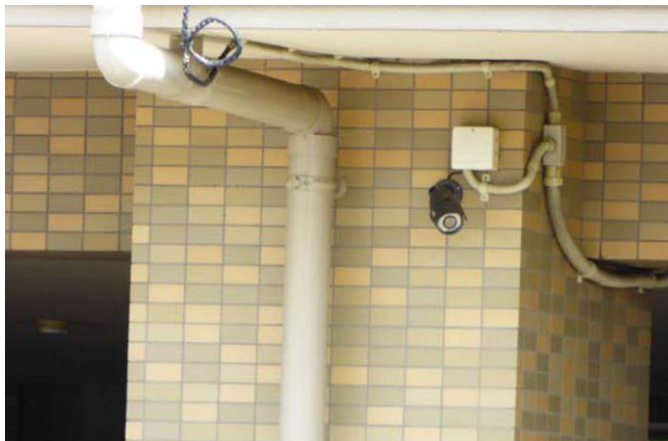
写真4 構造躯体には被害見当たらない
