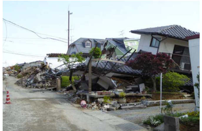
写真2 街区内部の被害状況
