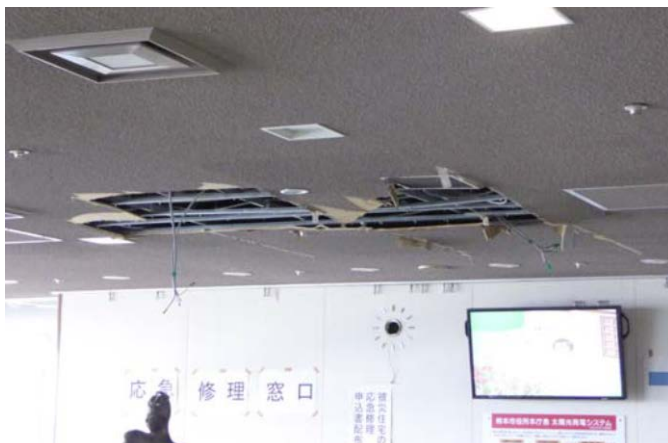
写真4 14階天井の破損
