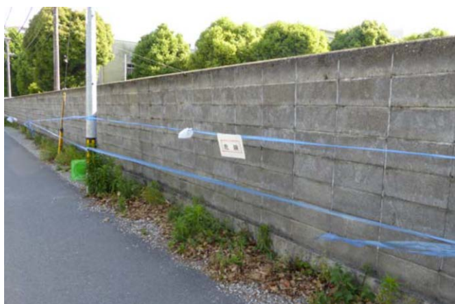
写真5 道路側に傾斜したブロック塀
