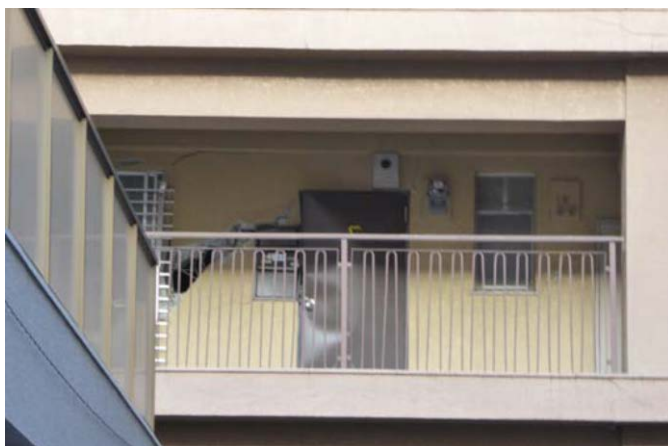
写真6 上層階では雑壁亀裂・ドア変形がある一方、骨組には大きな損傷は見られない。
