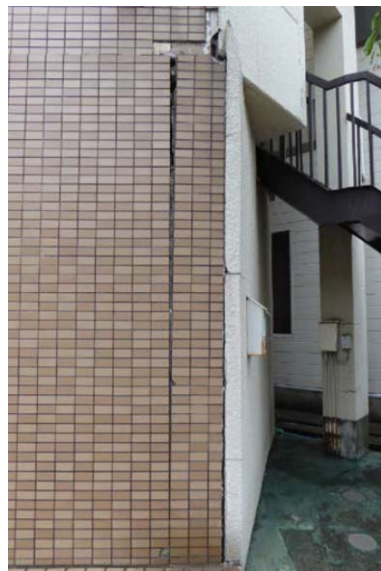
写真4 外壁パネルが脱落しそう
