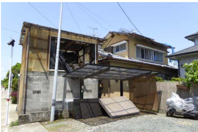
写真5 役場近隣の木造住宅
