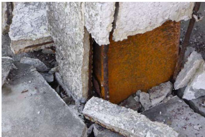
写真 2 1 階柱脚の様子
