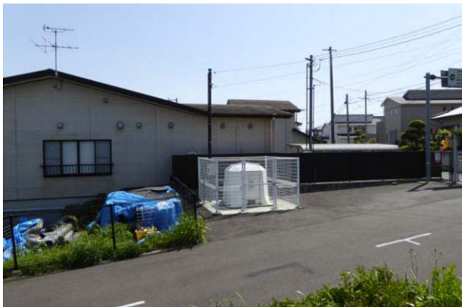
写真1 熊本市東部土木センター佐土原支所内設置
