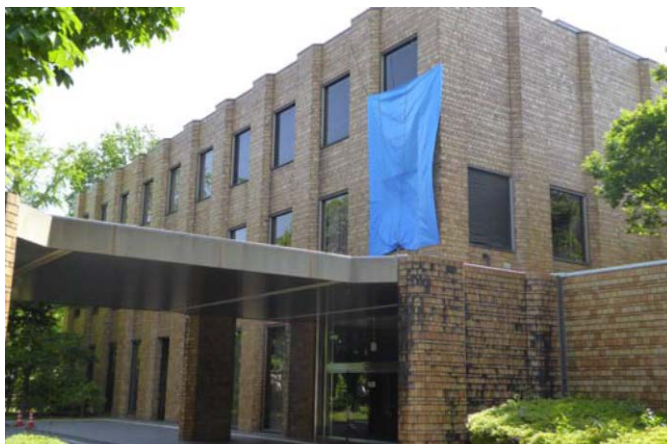
写真 6 議会棟で窓ガラスの破損
