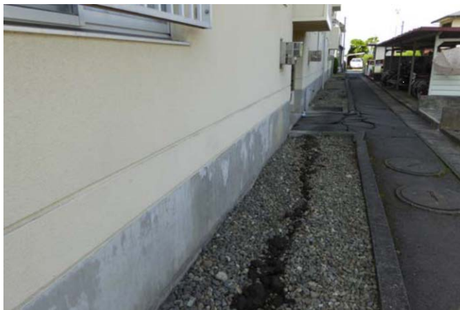
写真8 町営住宅北面地盤の亀裂
