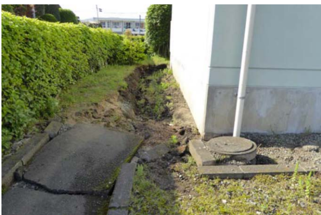
写真5 東側地盤と建物のずれ
