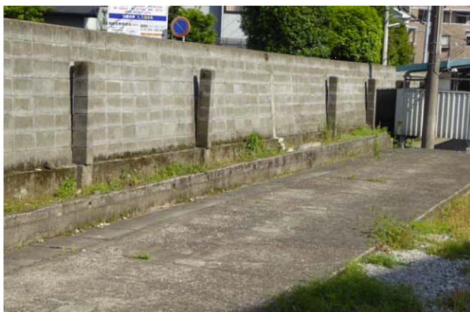
写真4 東門側ブロック塀が道路側に傾斜
