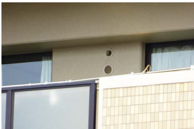
写真6 上層階の方立壁には被害なし
