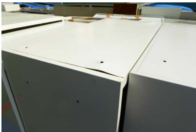
写真8 連結金具部分が揺れで引張られた
