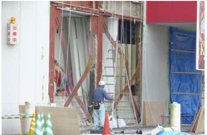
写真2 ブレースの座屈（西構面）
