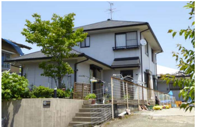
写真6 役場近隣の木造住宅
