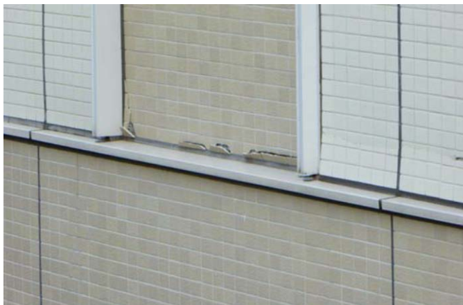
写真4 A棟の地下駐車場入口 GL に沿ってひび割れ
