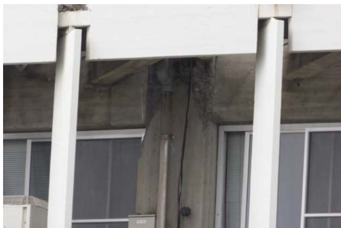
写真7 3階柱梁接合部被害
