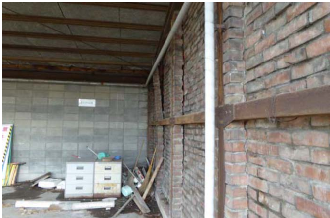
写真12 組積造倉庫の面外転倒・傾斜被害
