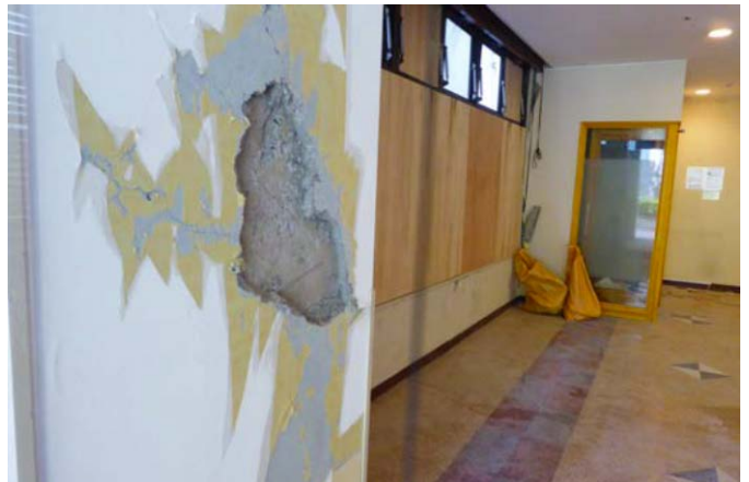
写真5 室内側1階柱の損傷状況
