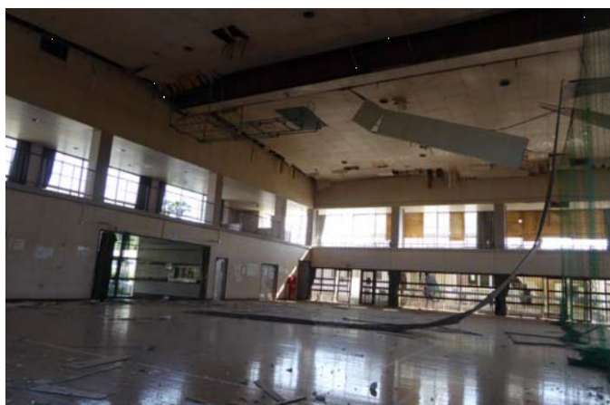
写真3 天井材落下被害
