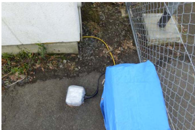
写真4 強震計が追加設置されていた
