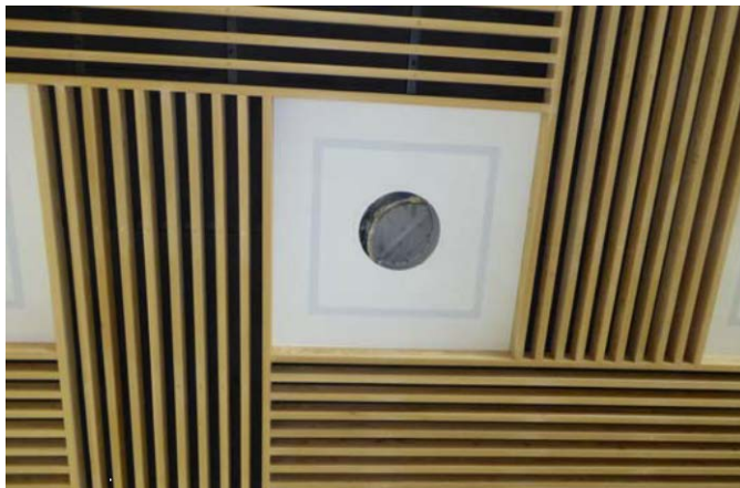
写真4 天井パネルとダクトのずれ
