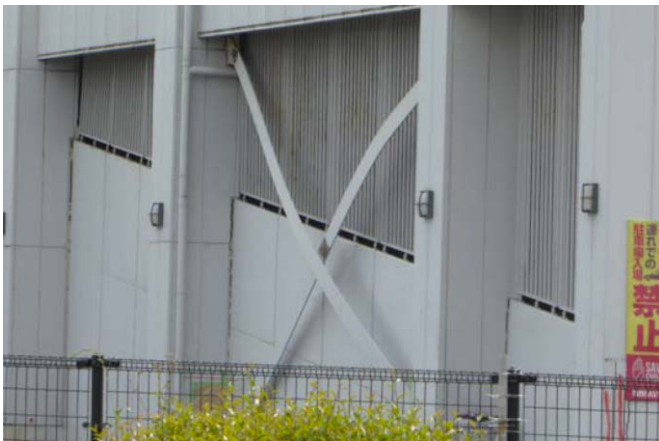
写真3 ブレースの座屈（北構面）
