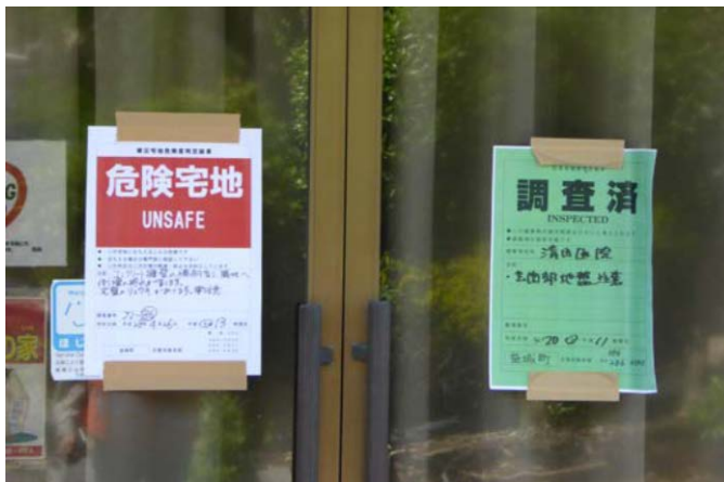
写真2 応急危険度判定済み（緑）
