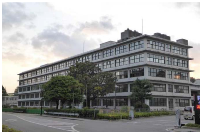
写真1 旧合同庁舎全景
