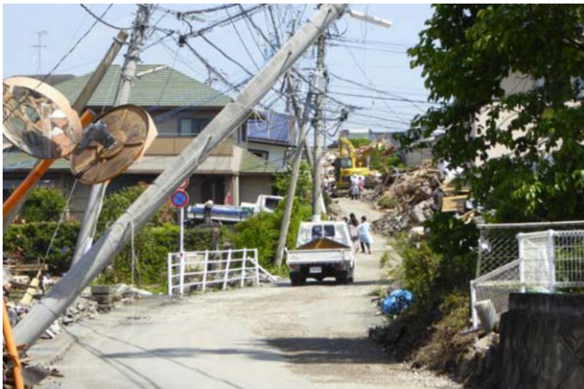
写真3 電柱が大きく傾く
