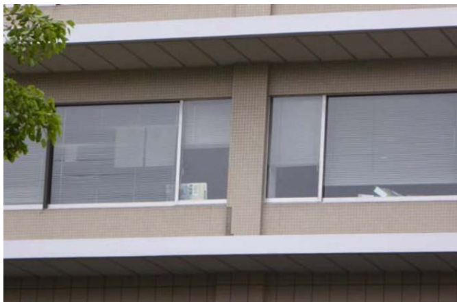
写真4 3階柱一腰壁取り合い部のタイル剥落
