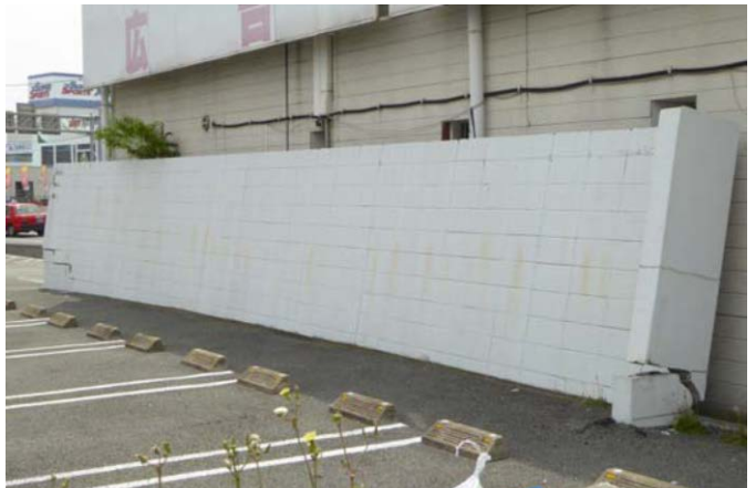
写真6 駐車場のブロック塀転倒
