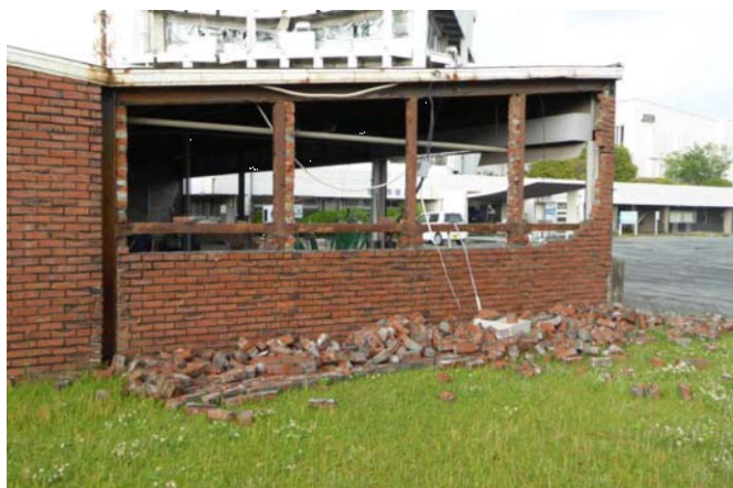
写真11 組積造倉庫の面外転倒・傾斜被害
