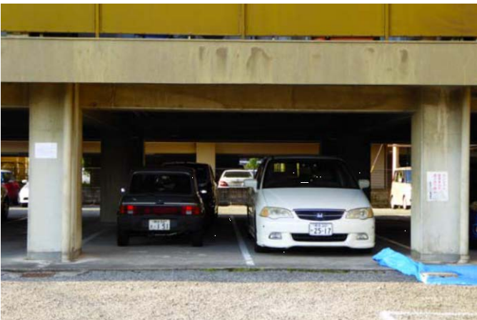
写真11 こちらのほうが古いがピロティ層崩壊せず
