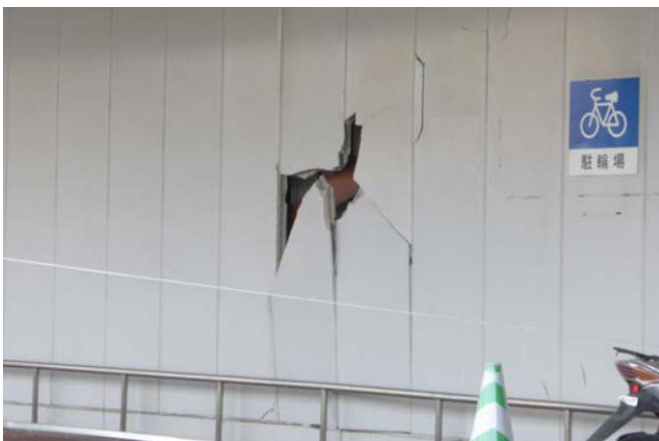
写真5 ブレース座屈により ALC パネルが面外破損
