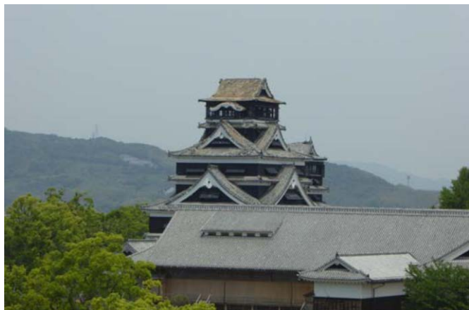
写真1 天守閣の瓦落下
