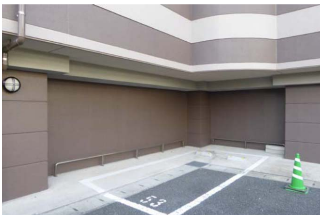
写真5 1階の柱・壁は無損傷
