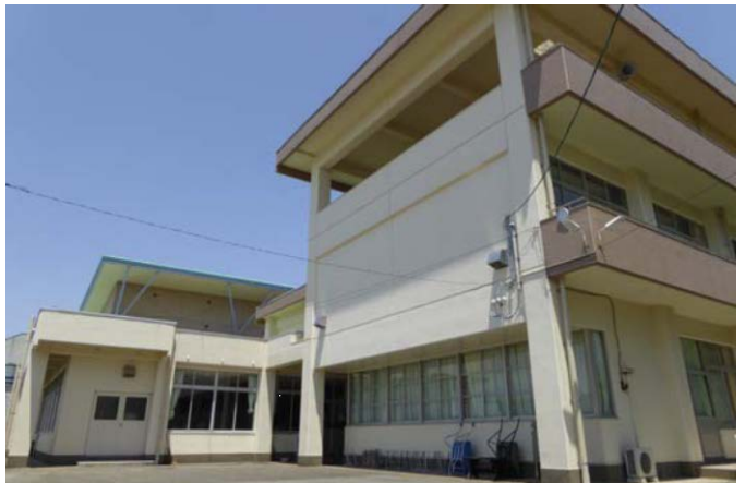
写真4 構造壁・雑壁ともに目立った損傷見られない
