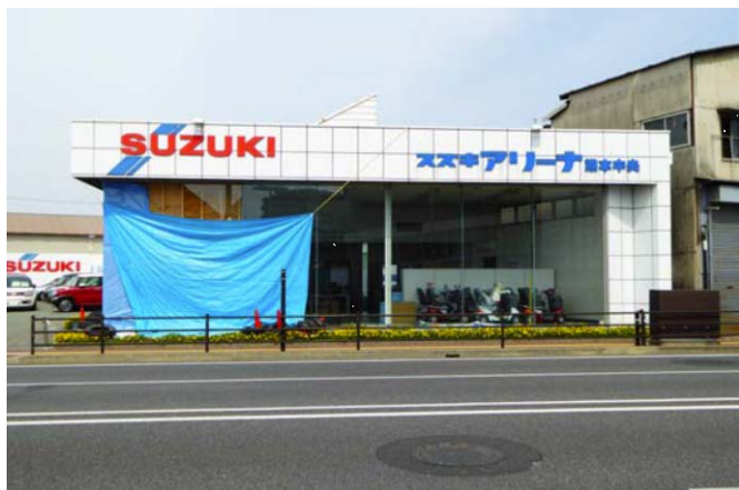
写真3 ショーウィンドウの破損
