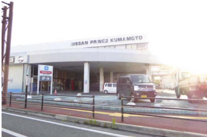
写真4 天井板が落下した販売店
