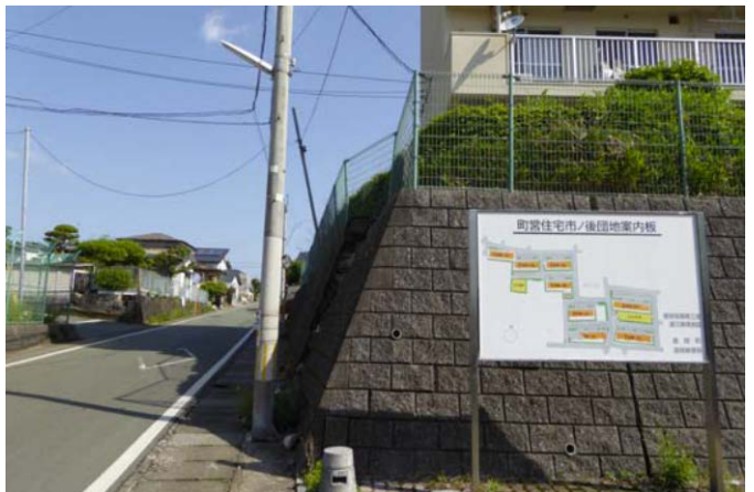
写真 4 町営住宅の擁壁
