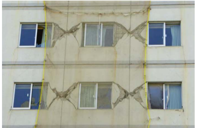
写真2 西構面外壁被害
