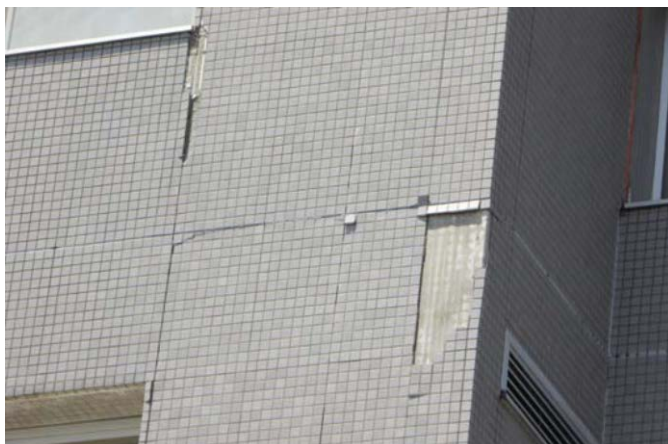
写真6 新しい庁舎にもタイル剥落などの被害
