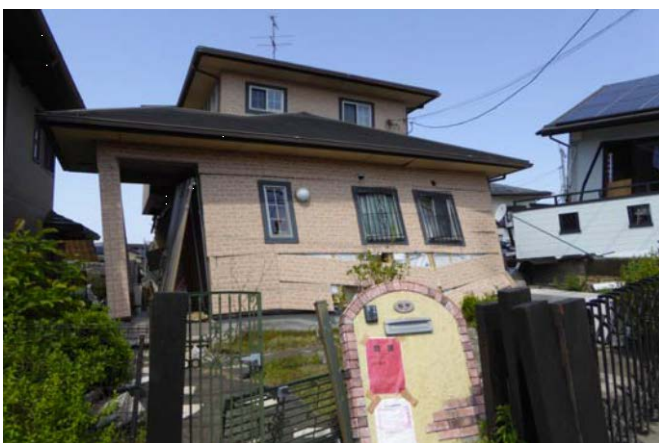
写真5 比較的新しい住宅も倒壊
