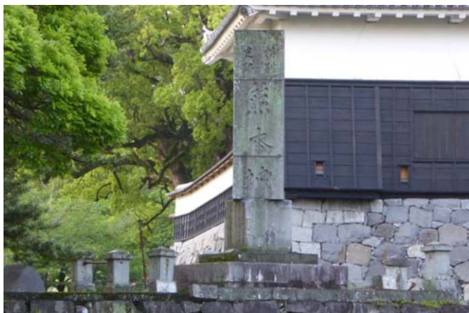
写真2 石塔のずれ回転
