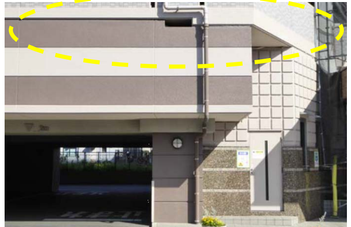
写真2 1階と2階の間に免震層
