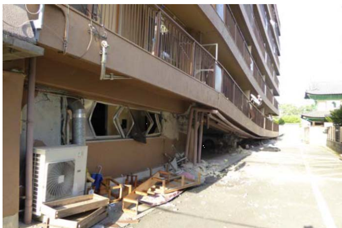
写真2 ピロティ部分の層崩壊
