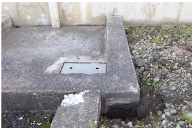
写真8 入口縁石のずれ
