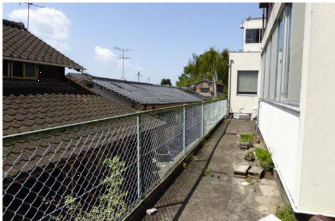
写真4 盛土擁壁部分には被害なし
