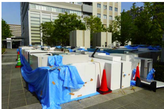
写真7 庁舎から出たと思われる大量の被災什器
