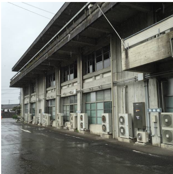
写真3 人吉市本庁舎 (南面)
