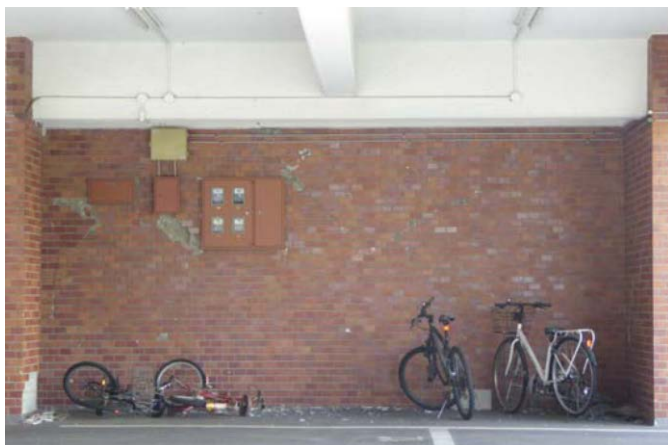
写真4 耐震壁にせん断ひび割れ
