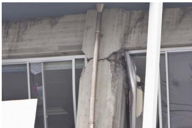
写真9 5階柱頭被害
