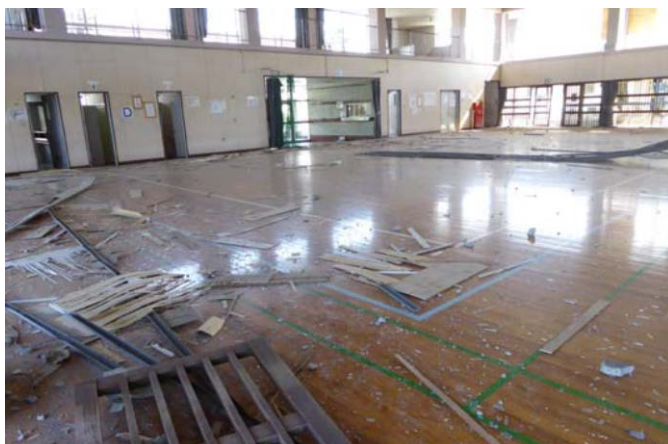
写真6 天井材落下被害
