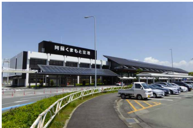
写真1 空港ターミナル全景
