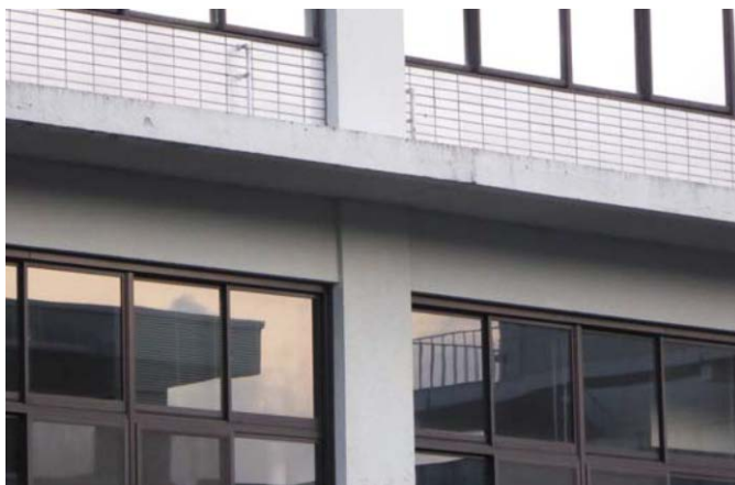
写真4 柱・梁部材に被害が見当たらない
