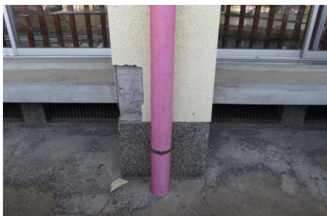
写真7 柱脚部の仕上げ一部剥落
