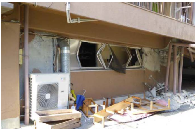
写真4 コンクリートの問題か？
