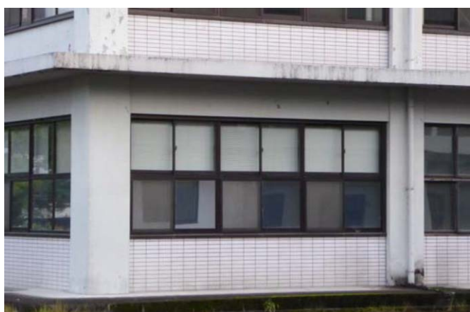
写真3 1号館1階北側構面（損傷見当たらない）
