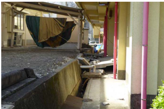
写真6 盛土擁壁の倒壊（左：公民館，右：体育館）
