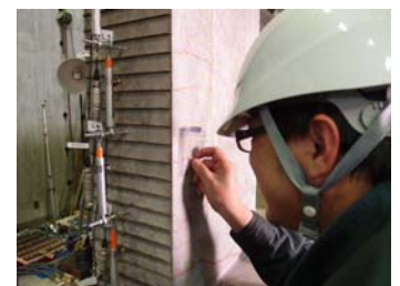
写真4 ひび割れ幅の計測
