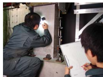
写真3 ひび割れ図の作成
