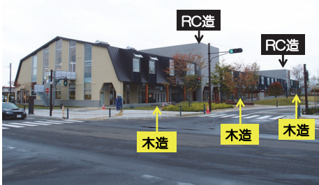
写真1 RC造-木造平面混構造建物例
