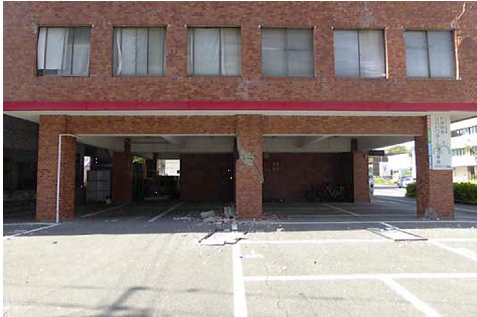
写真1 ピロティ部の様子（南構面）
