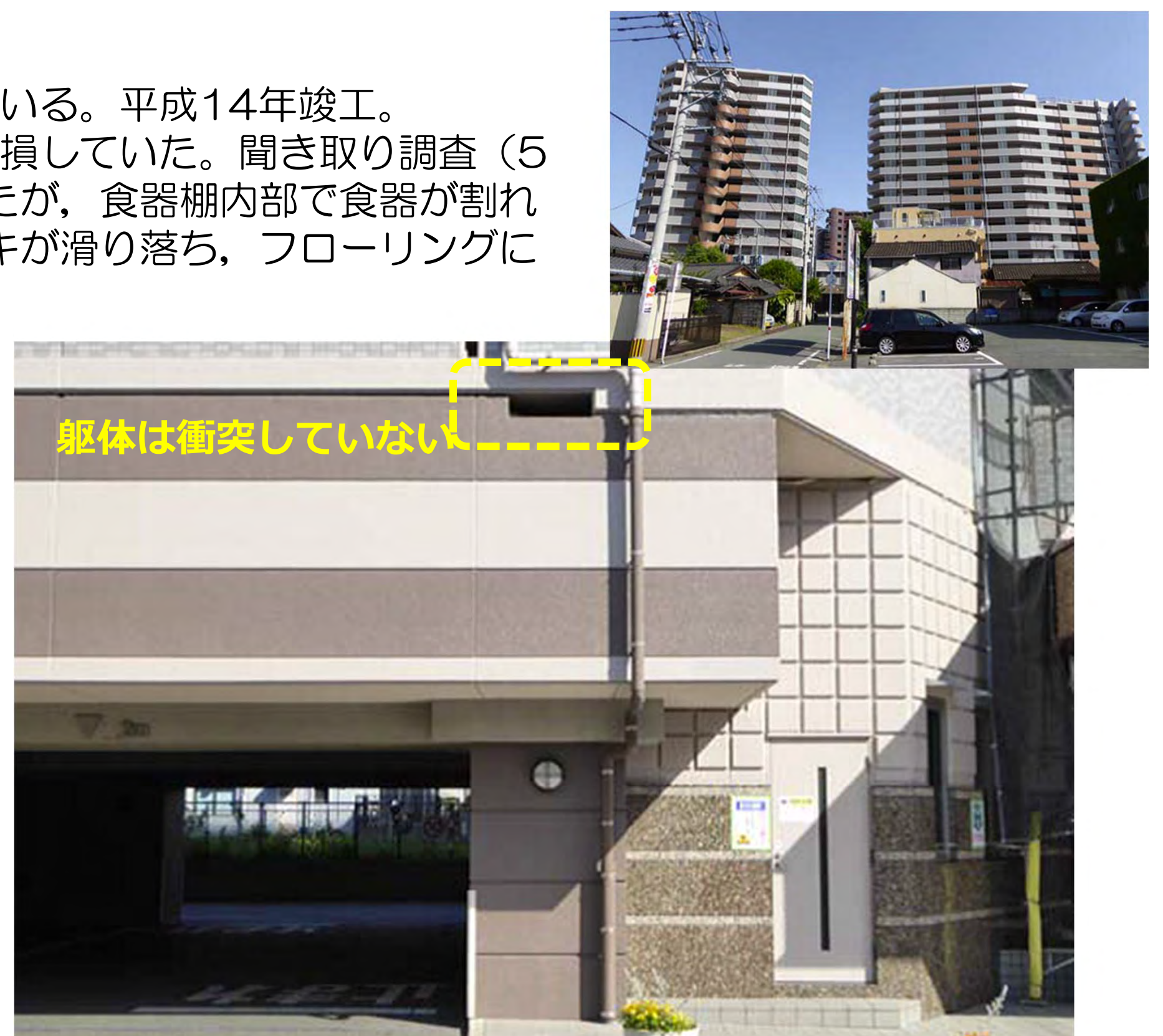
写真2 1階と2階の間が免震層になっている
