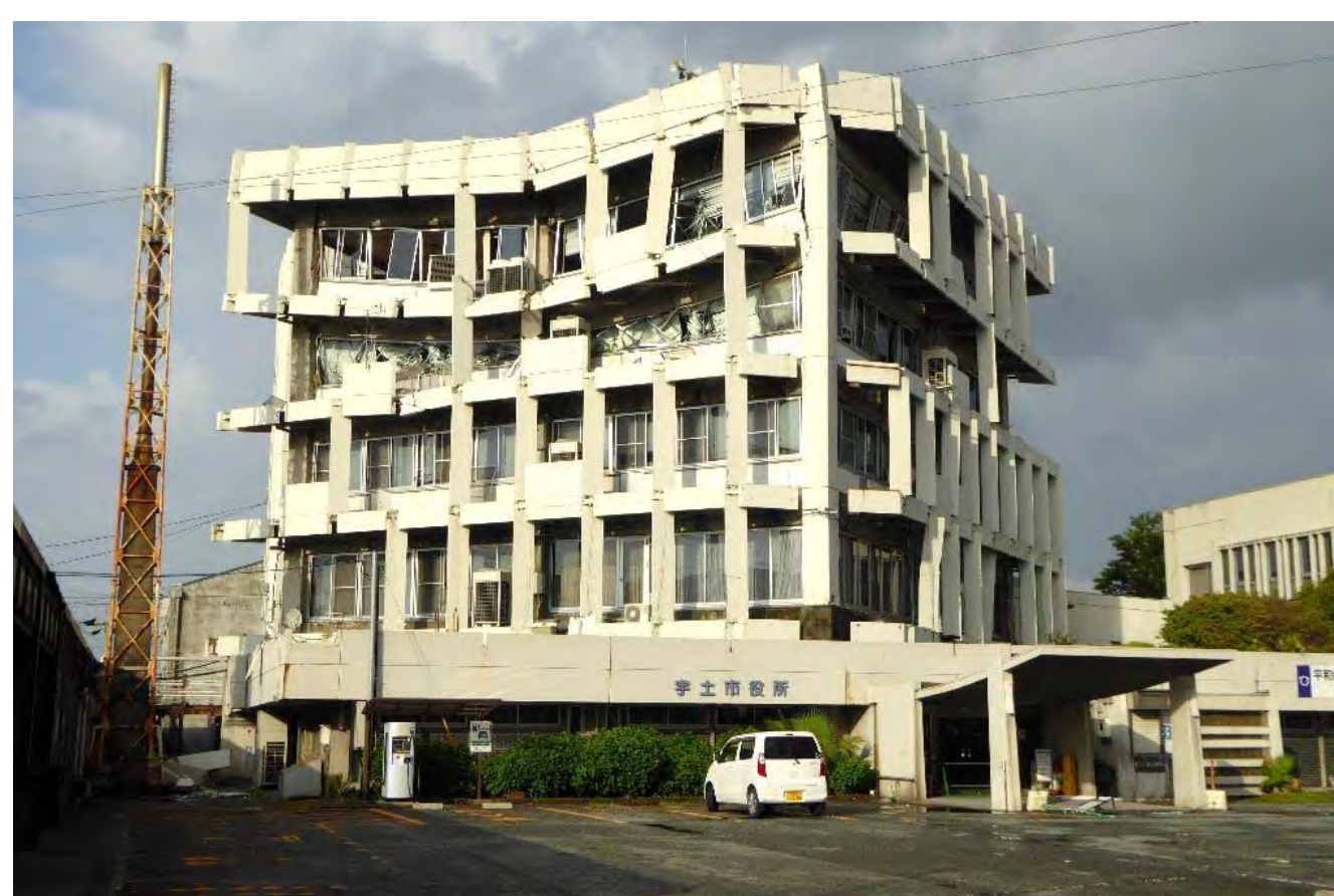
写真1 市庁舎（南東構面）
