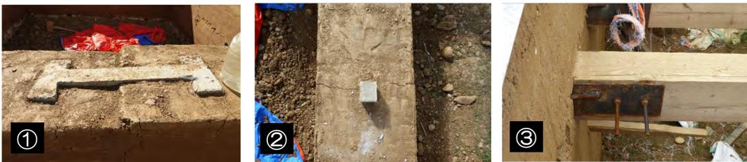
⇒ 版築ブロック境界（施工上の継ぎ面になる部分）に工場生産可能なRC造の補強材（①H型クサビ，②直方体ダボ）と2階床を支える大梁の埋込み部に③鋼製アンカーを設置。
