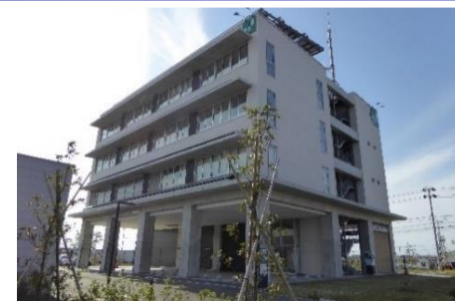
▲ピロティ形式の津波避難ビルの一例
