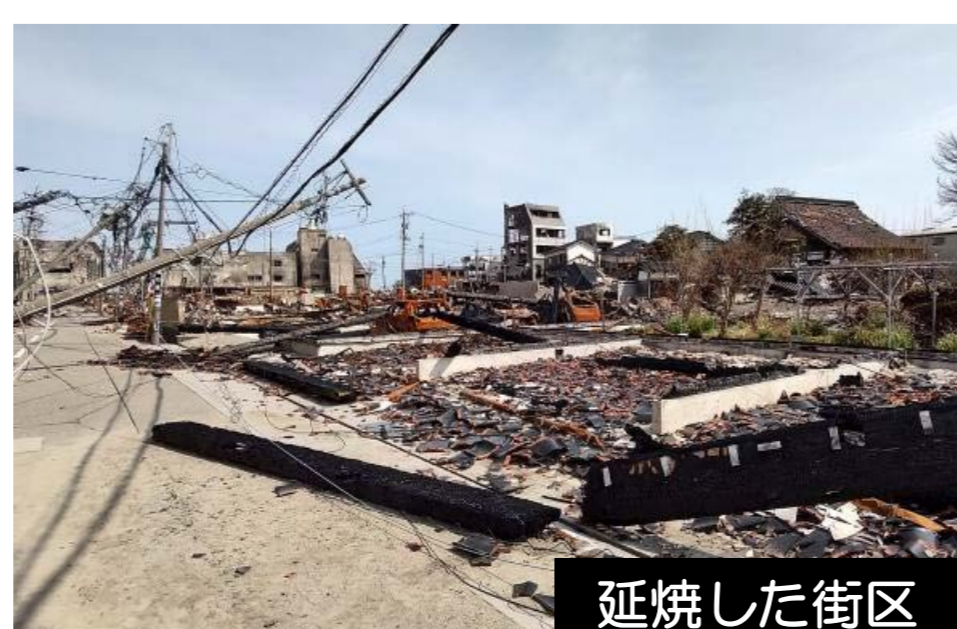
延焼した街区
