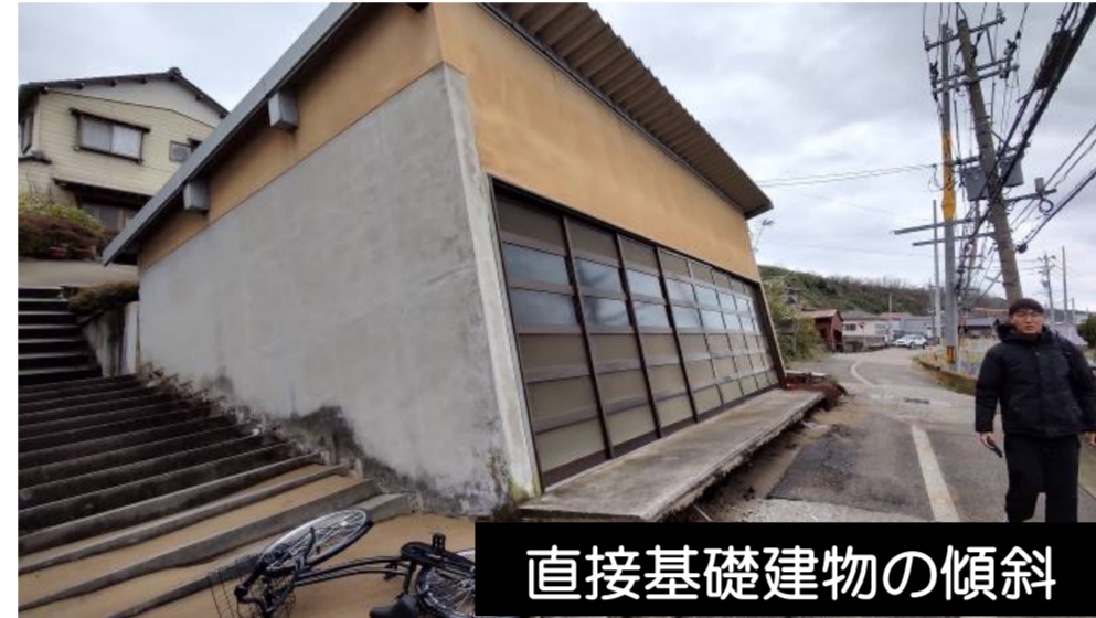
不同沈下により折損した木造家屋
