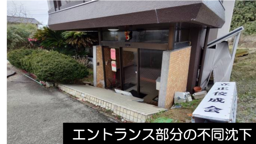
RC造3階建の傾斜
