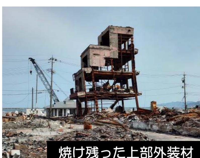
延焼した街区
