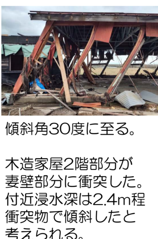
S造倉庫傾斜 (筋交破断)
