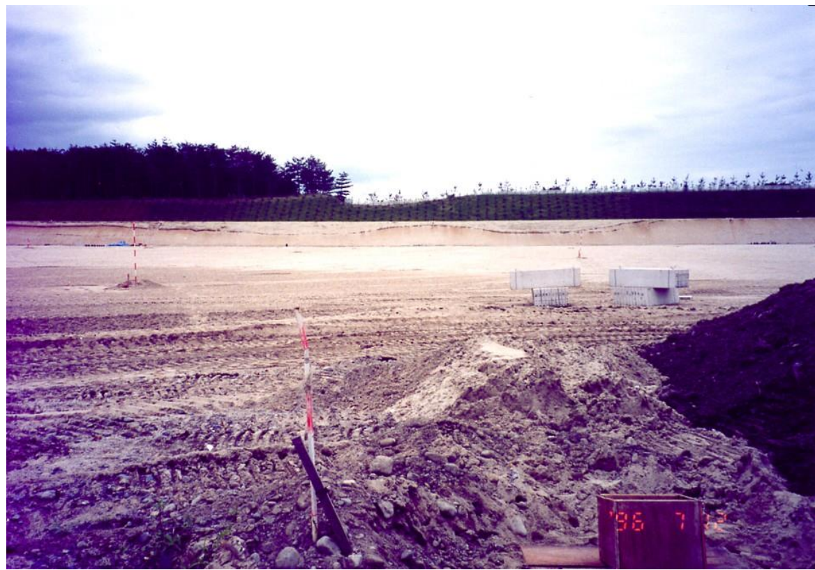
造成工事の状況
