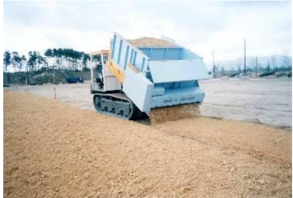
クローラダンプによる散布状況
