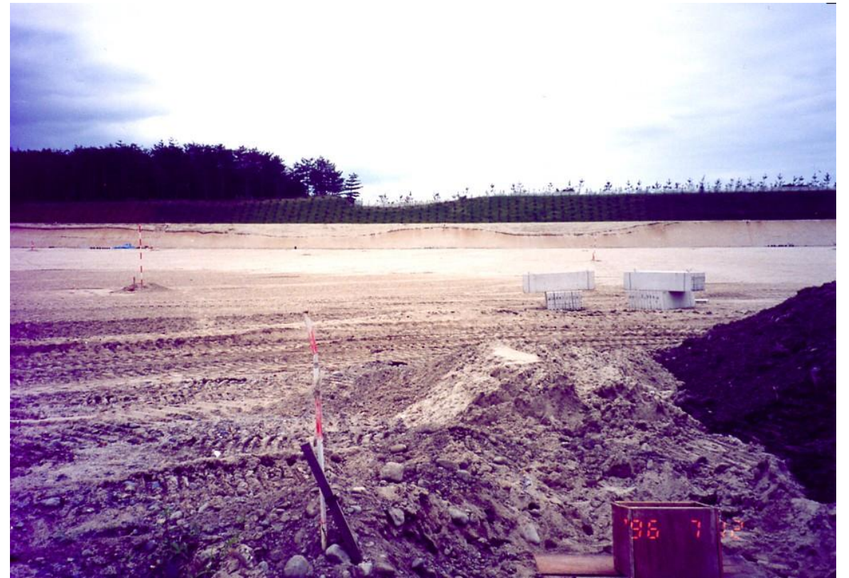
造成工事の状況
