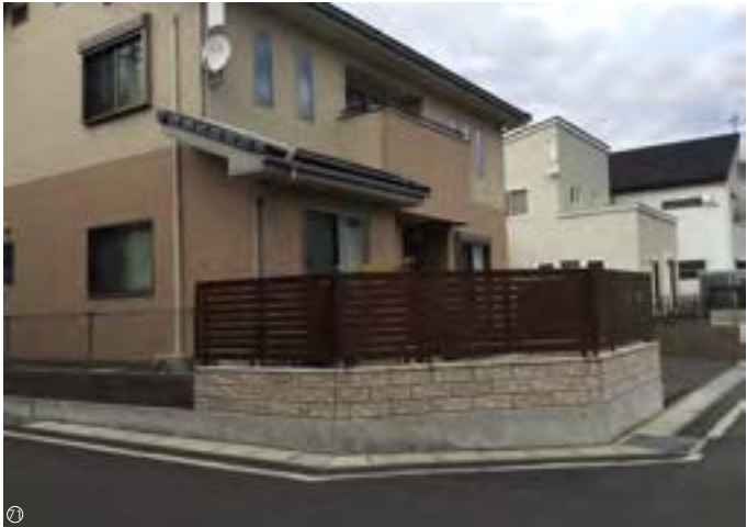
⑦ 部分的高上げによる自力再建 / Self-help reconstruction by partial elevation
